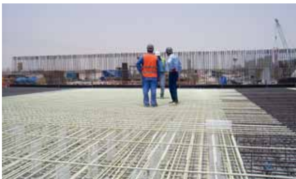
Funderingsplaat transformator aluminiumsmelterij Qatalum, Qatar
