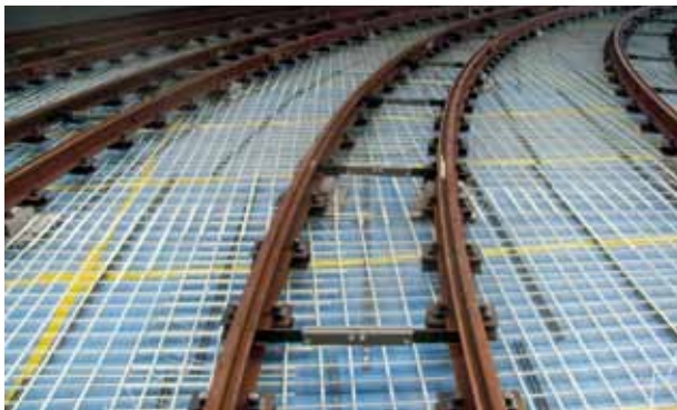
Funderingsplaat trein rangeerterrein in Basel, Zwitserland
