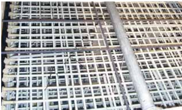
Fundering van het IBM Nanotech Center Zürich, Zwitserland
