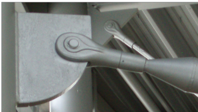
Drukstangensysteem bevestigd aan een aansluitplaat
