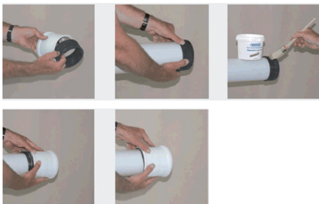
Afb. 5.3 Montage van de expansiezijde van de steekmof.
