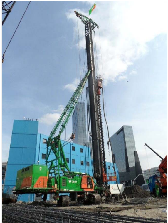
Buisschroefpaal, Rotterdam CS
