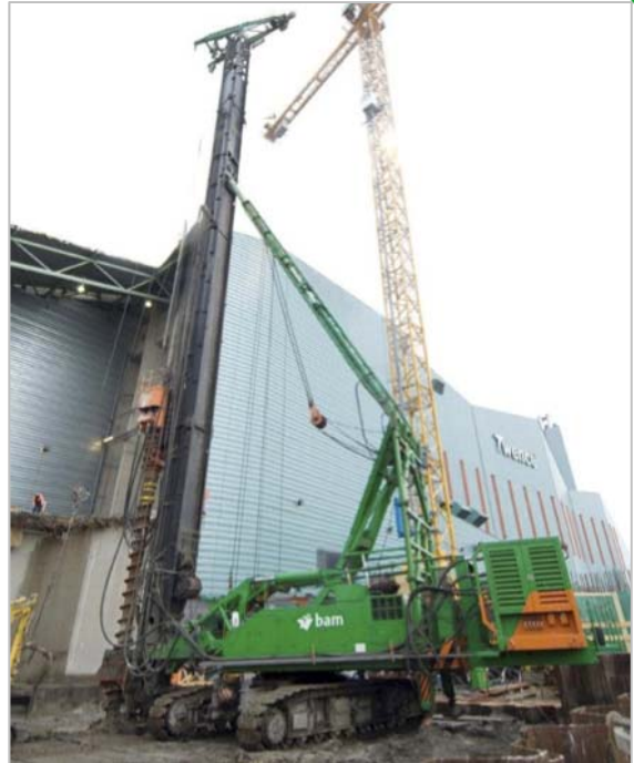
Buisschroefpaal Twence, Hengelo
