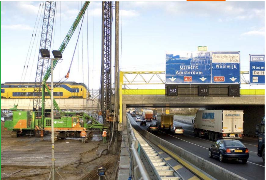
Verbuisde schroefpalen direct naast kunstwerk, A2 Den Bosch
