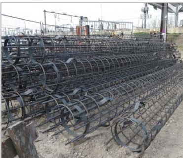
Wapeningskorven buischroefpaal
