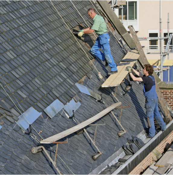
Dakloopsteiger op de kapel van het Sint-Pieters- en Bloklansgasthuis in Amersfoort. Let op de correctie van de stijglijn
