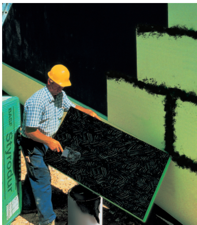
Afb. 23: Volvlakse verlijming van Styrodur® platen en sponningen, inclusief afstrijken van de naden na het plaatsen.
