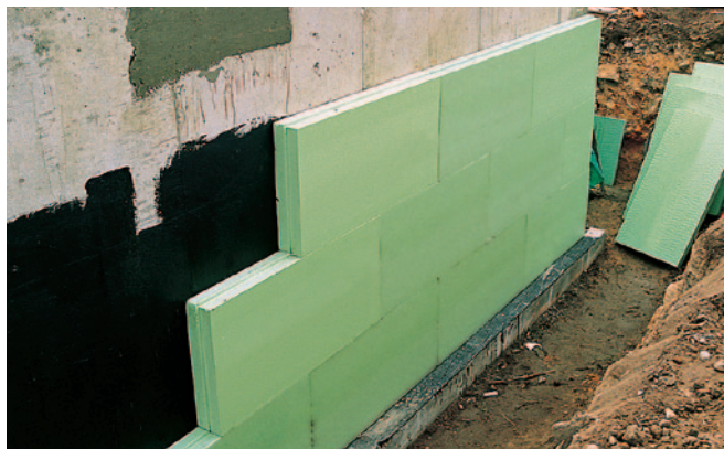
Afb. 3: Verwerken van Styrodur® platen in halfsteensverband.
