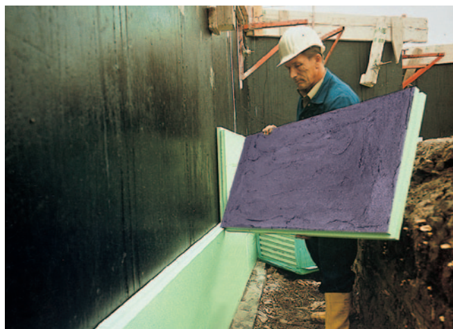
Afb. 4: Opzetten van de Styrodur platen op de betonnen plint.
