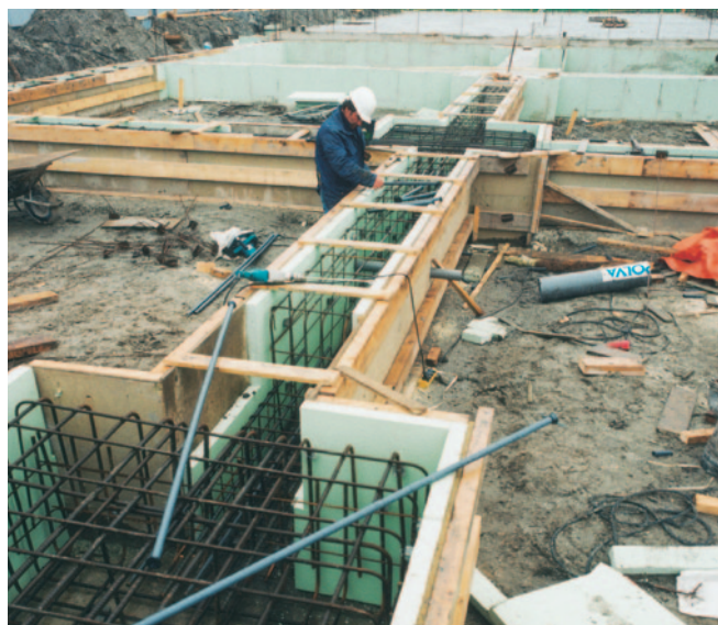
Afb. 13: Bekisting met Styrodur.
