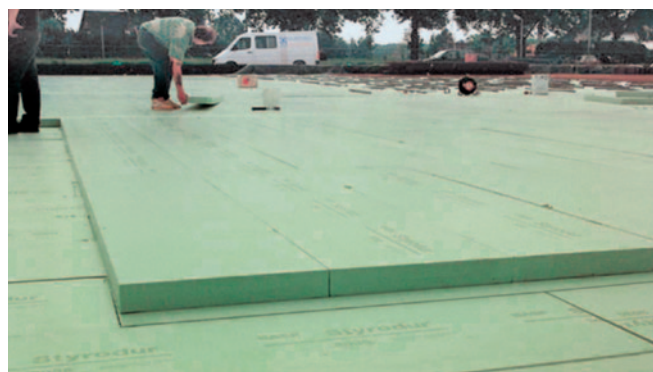
Afb. 26: Styrodur® vloerisolatie voor een Passief Huis.
