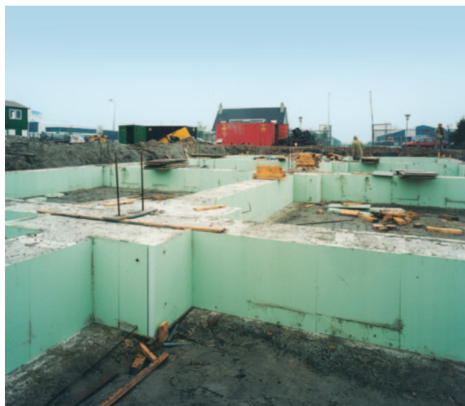
Afb. 14: Geïsoleerde funderingsbalk na ontkisten
