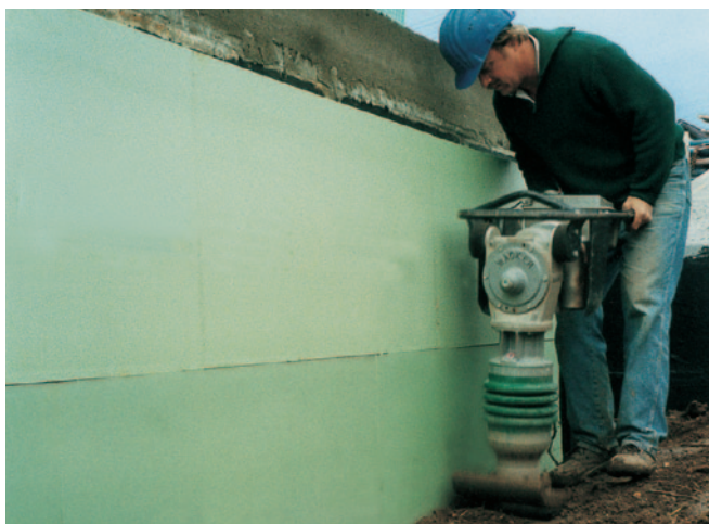
Afb. 24: Vullen in lagen en mechanisch verdichten van de grond.
