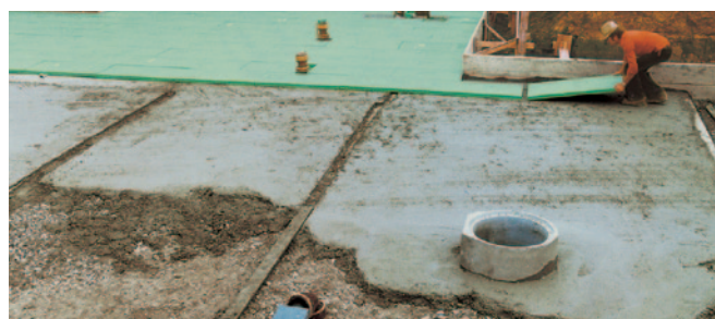
Afb. 16: Werkvloer uit beton voor het leggen van de vloerisolatie.
