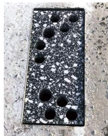
Meterkastblok voor standaard- of stadsverwarming.
