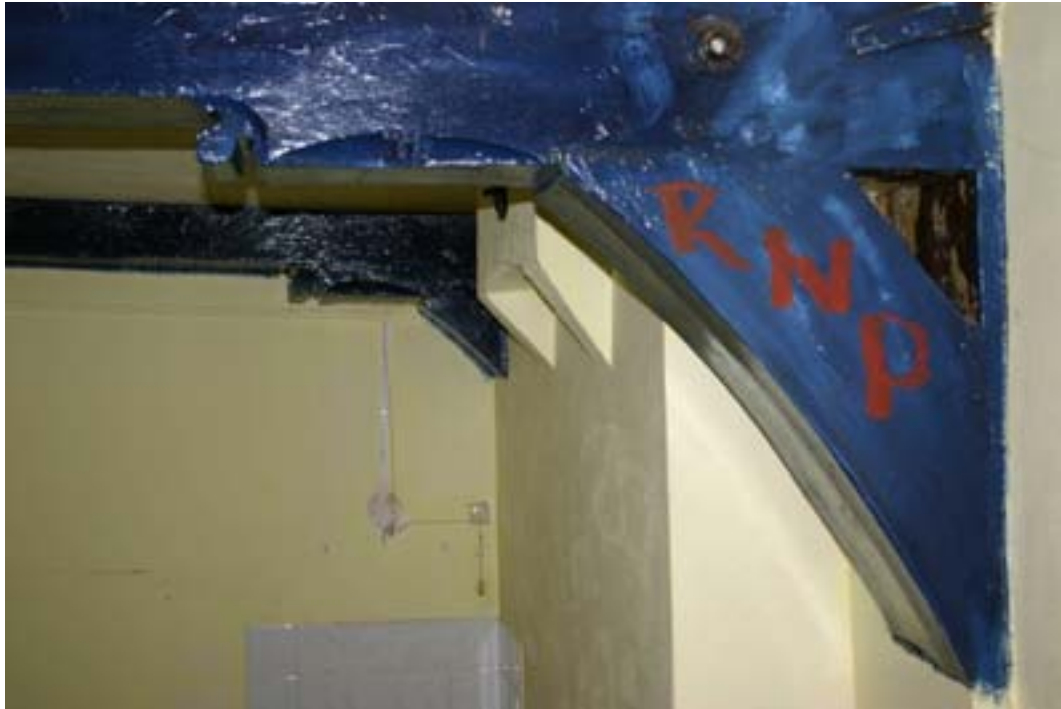
Peerkraalsleutelstuk met korbeel op de eerste verdieping (foto BMA).
