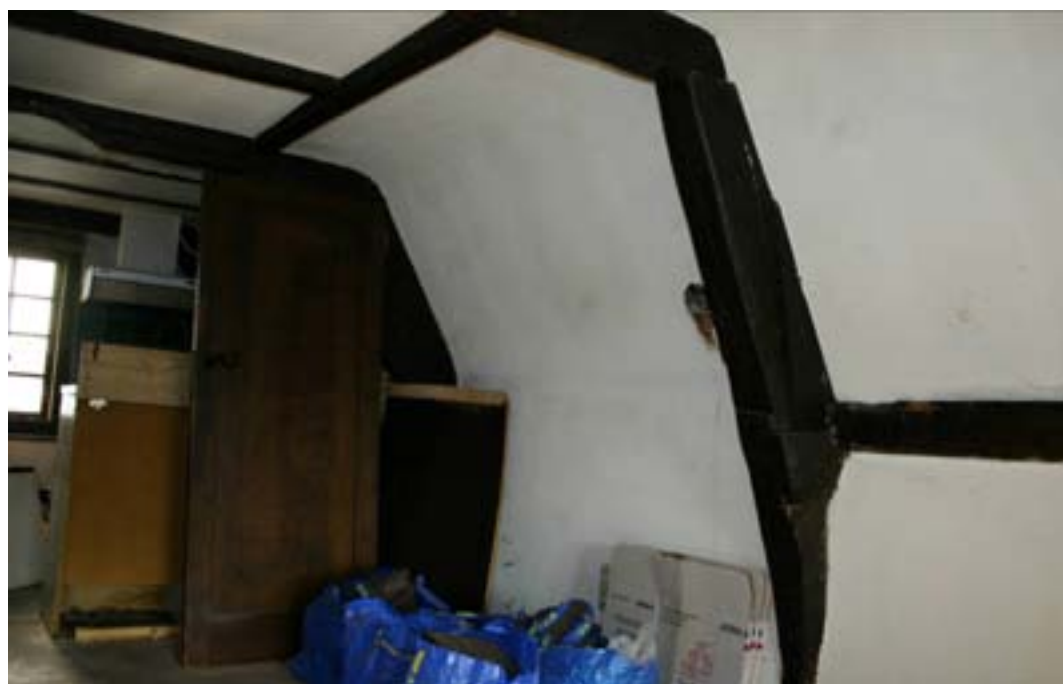
Impressie van de hergebruikte spanten.
