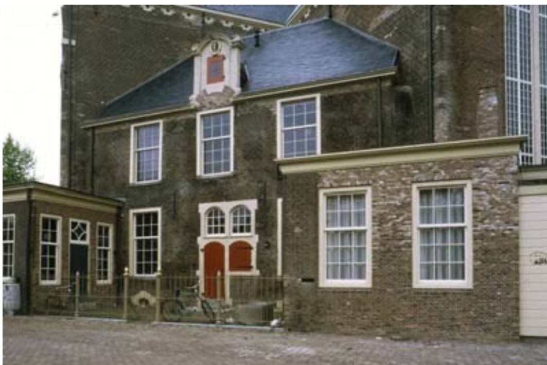
Aanbouw Noorderkerk (1621) met hergebruikt hout in de kapconstructie uit 1497.
