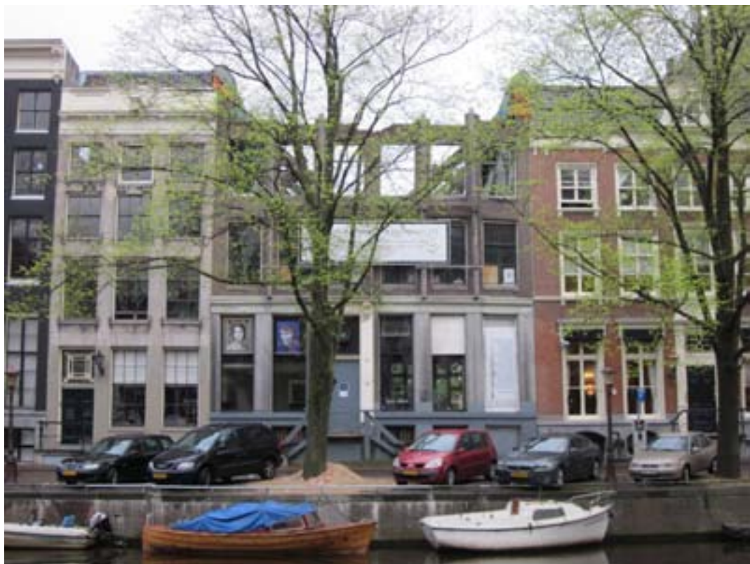
De onttakelde voorgevel van Herengracht 132 in april 2012.
