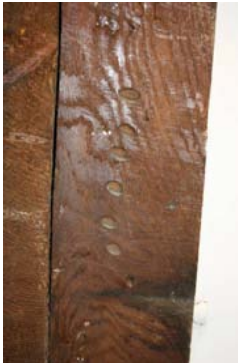
Kromme Waal 22; voorgevel en telmerk 'zes' in het houtskelet van het voorhuis.
