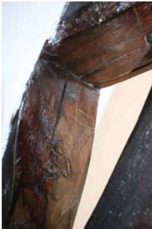
Nieuwezijds Voorburgwal 16: voorgevel en merk in een van de kromstijlen (foto's Michel van Dam/ BMA).
