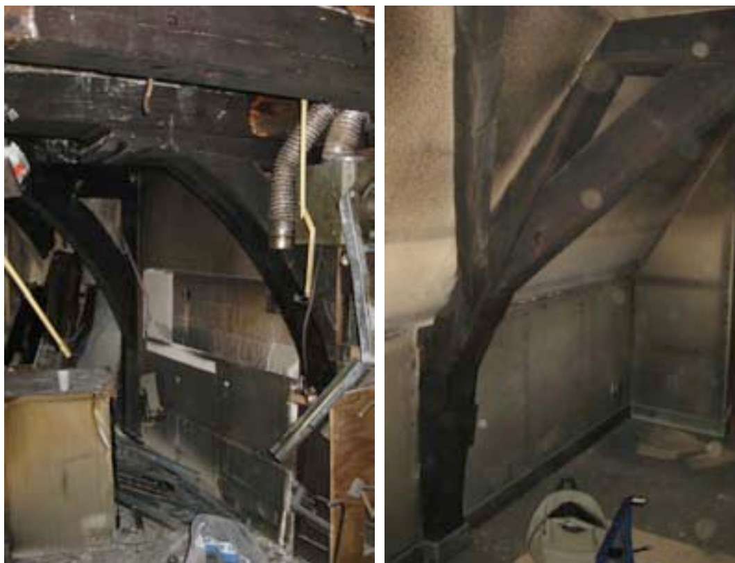
Korbeelstel op de tweede verdieping en kromstijl op zolder, zoals aangetroffen bij het begin van de herstelwerkzaamheden in maart 2012
