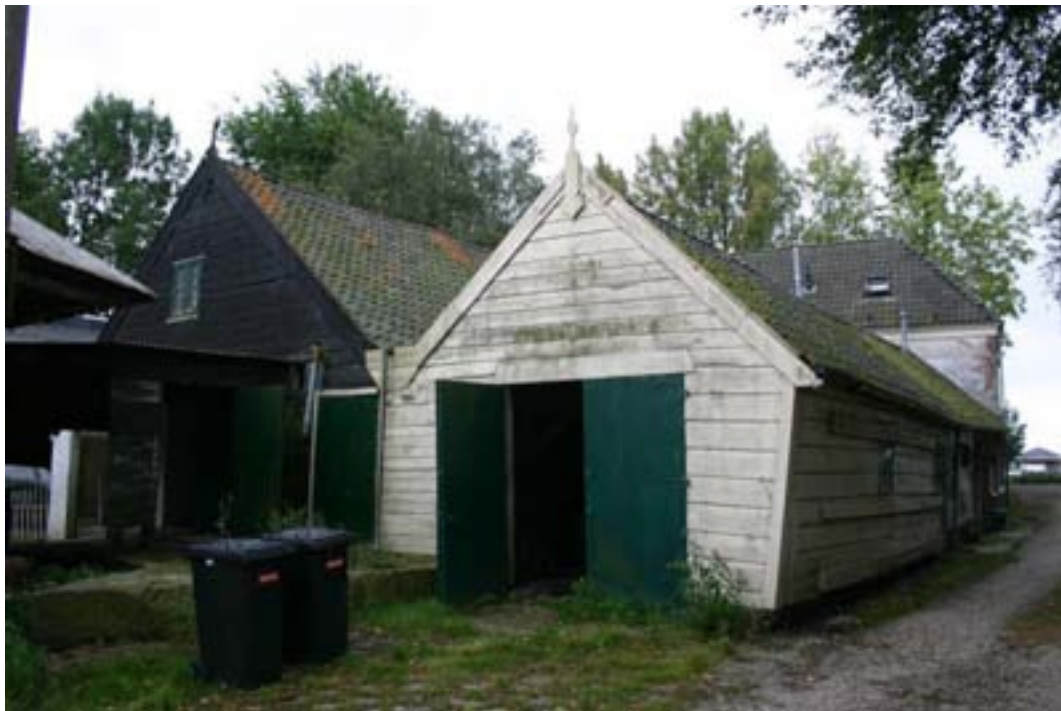
De twee onderzochte achteraanbouwen van Oudekerkerdijk 225.
