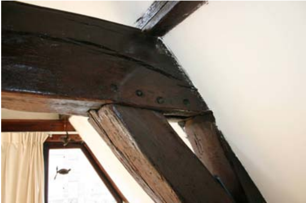
Sporen van hergebruik in de kapconstructie van Nieuwezijds Voorburgwal 16 (foto Michel van Dam/BMA).
