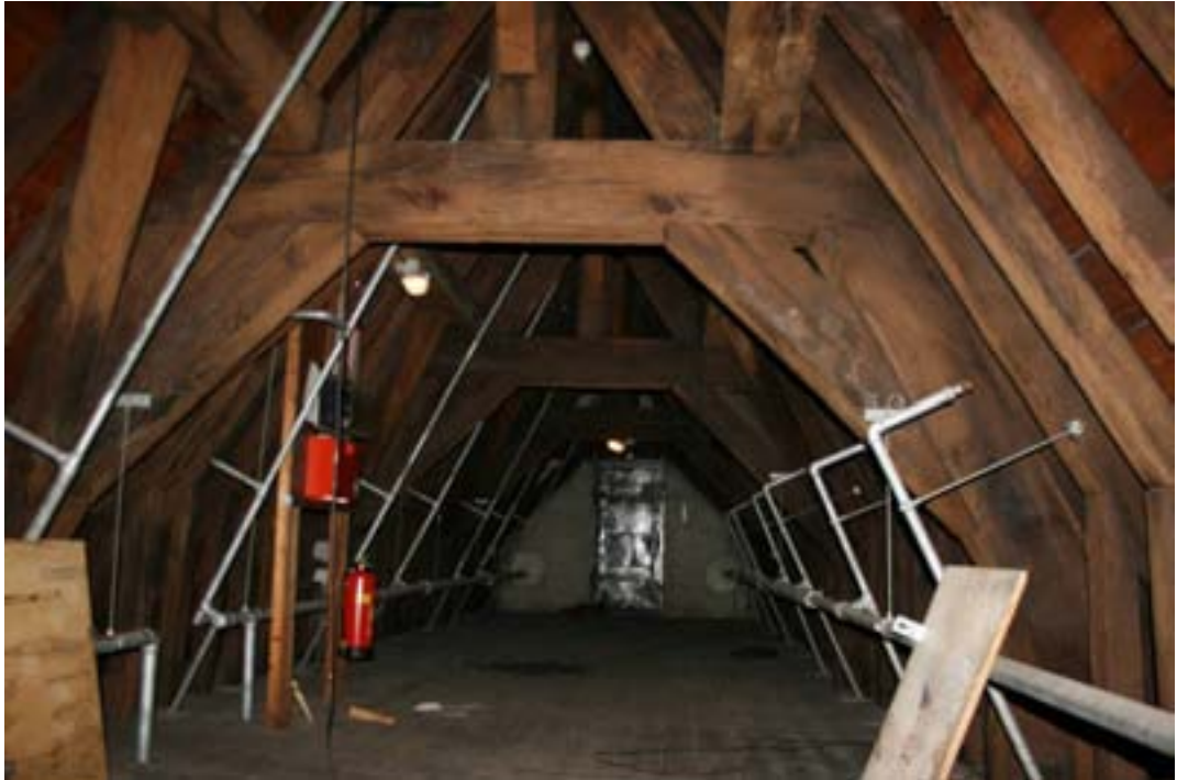
De noordelijke hoofdkap, gezien naar het zuiden (foto BMA).
