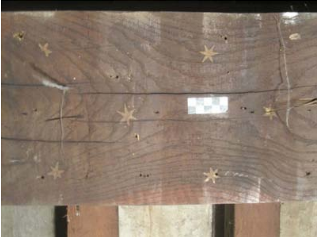
Geschilderde sterren op een van de moerbalken van de begane grond (foto David Derksen/ BMA).
