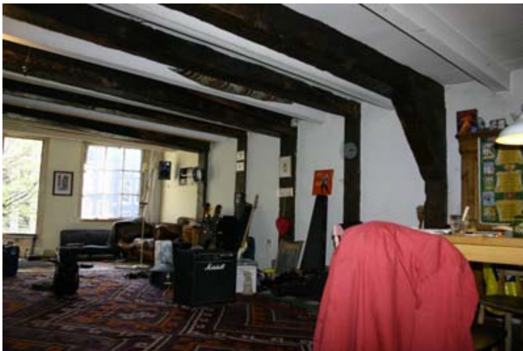
De eerste verdieping van het pand met het houtskelet in 2006.
