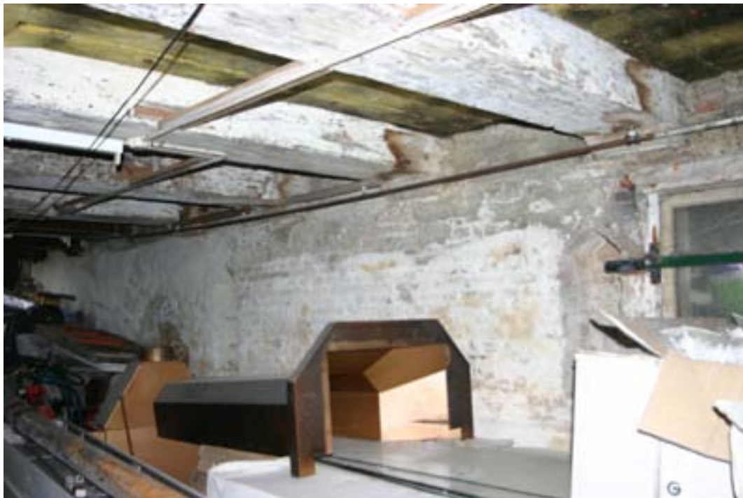
Kromme Waal 16, balklaag van hergebruikt grenenhout.
