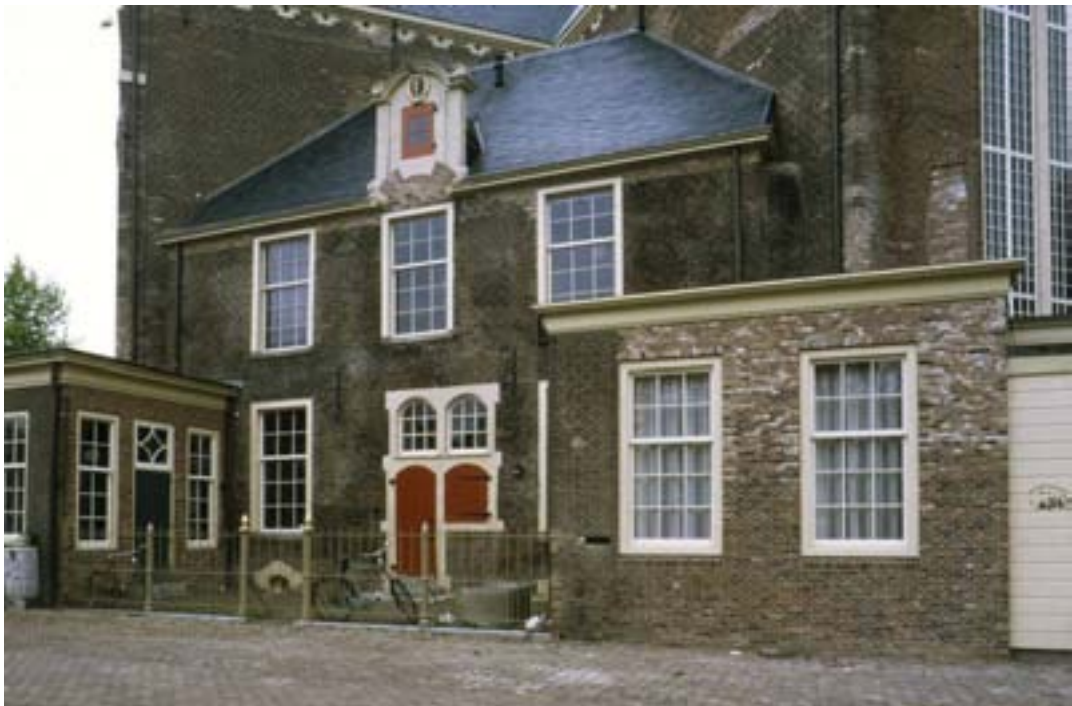
Het doodgravershuis aan de Noorderkerk.
