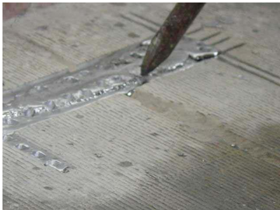
Fig. 25: Priemen van het lood om lood te verdichten.
