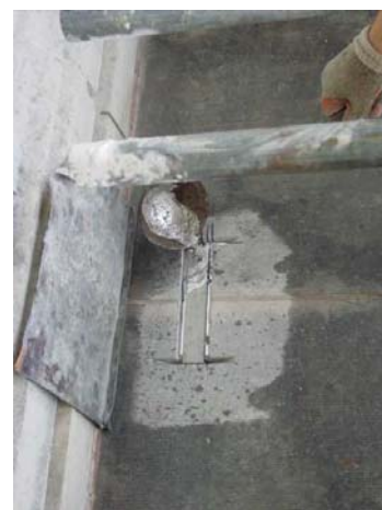
Fig. 22: Aangieten met lood.
