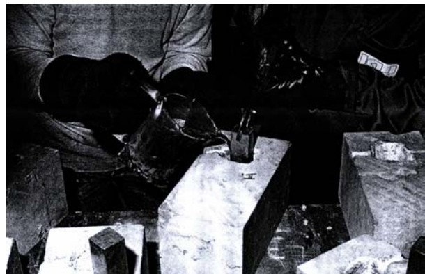
Fig. 14: De ankerstaaf wordt gepositioneerd en gesmolten lood wordt in de ruimte tussen de ankerstaaf en het gat gegoten (ERCAN S. e.a., 1995: 84).
