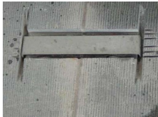
Fig. 20: Positionering van het inoxanker in het gat.
