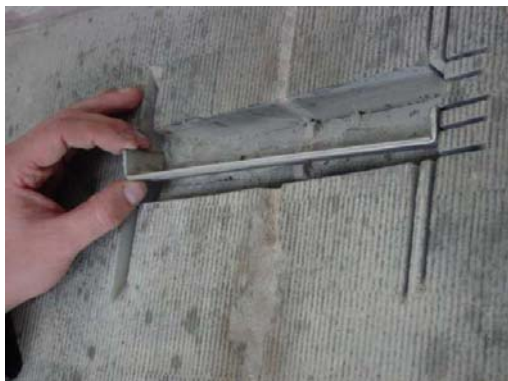
Fig. 19: Geometrie van het gat in het werkstuk en van het inoxanker.
