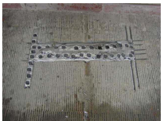
Fig. 26: Gepriemd lood, eindtoestand verbinding.
