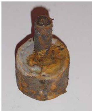
Fig. 77: De corrosieproducten die van de staaf van getrokken staal lopen, sluiten de spleet vrij vlug af waardoor geen verder vocht met een hoge concentratie aan zouten in de spleet kan penetreren.
