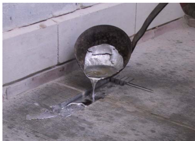
Fig. 21: Aangieten met lood.
