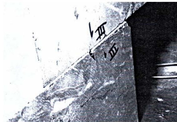
Fig. 18: Als het lood uit het kleinere kanaal loopt, kan besloten worden dat het aangieten met lood goed uitgevoerd is (ERCAN S. e.a., 1995: 86).
