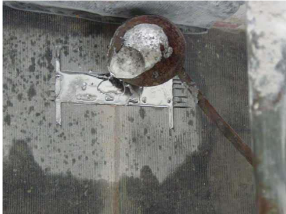
Fig. 23: Aangieten met lood en stollen van het lood.
