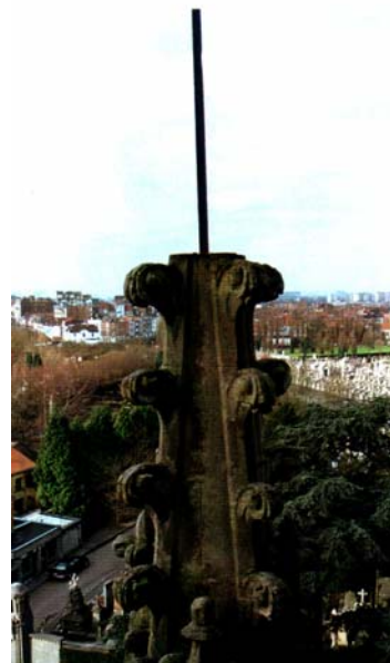
Fig. 11: Pinakel met ankerstaaf (BREDA K., 2002, 288).
