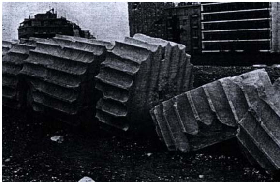
Fig. 28: Bij aardbeving ingestorte kolom doordat de houten pinnen weggerot waren (COWAN, 1977: 46).
