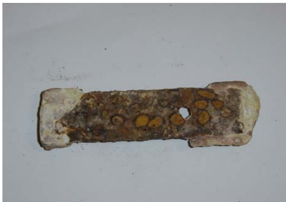
Fig. 30: Corrosie van anker (Sint-Martinusbasiliek in Halle).
