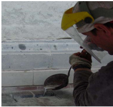
Fig. 27: PBM's, zoals een gezichtsbeschermer, handschoenen en stevige werkkledij. Ook het dragen van een stofmasker is aan te bevelen.
