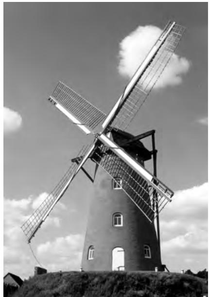
Figuur 51 Molen te Oelegem, na de restauratie © Lhoist
