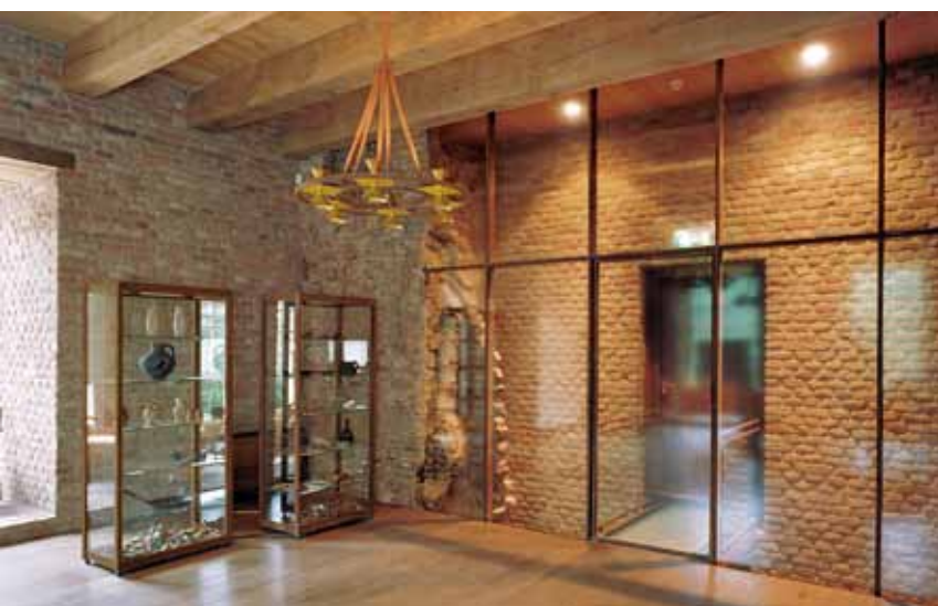
Een verdwenen muur van het tot voor kort ruïneuze kasteel Nederhemert is bij gebrek aan voldoende gegevens niet gereconstrueerd, maar vervangen door een wand in eigentijdse vorm en materialen
