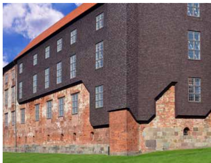
Koldinghus in Kolding (Denemarken): de ruïne van het uitgebrande kasteel is door een reversibele, in materiaal en kleur duidelijk afwijkende completering voor verschillende doeleinden geschikt gemaakt
