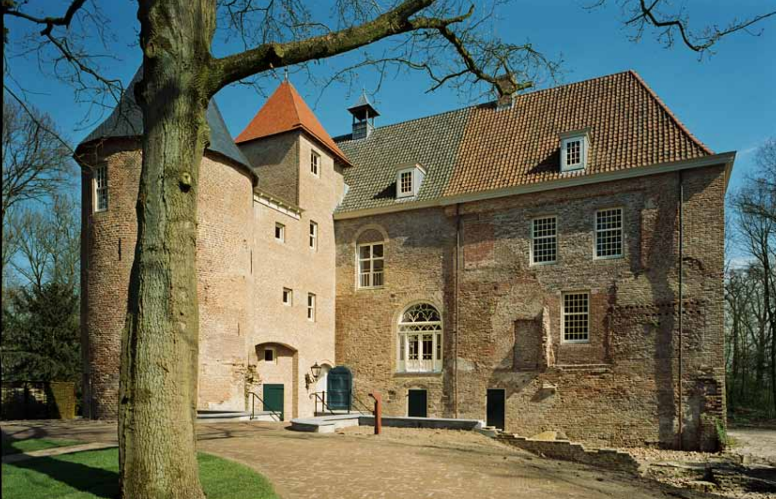
Bij de herbouw van het in 1945 verwoeste kasteel Nederhemert is niet teruggerestoreerd naar de situatie van vóór 1945, maar naar een achttiende-eeuwse situatie zonder ingangsvleugel en met een lage 'keukentoren' (niet zichtbaar op de foto)
