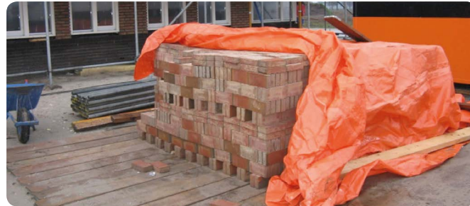
Materiaal afdekken. Bron: TBB/Weerverletbestrijding
