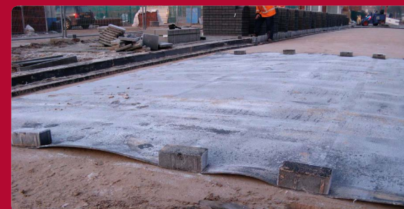
2. Afdekken van de zandbaan met landbouwfolie. Bron: TBB/Weerverletbestrijding
