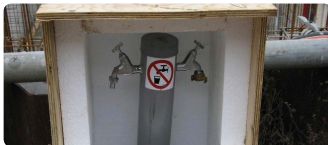
Vorstvrije bouwwatervoorziening. Bron: TBB/Weerverletbestrijding
