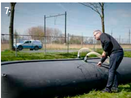
7. Vul de SLAMDAM® tot het een hoogte van ca. 67 cm.
