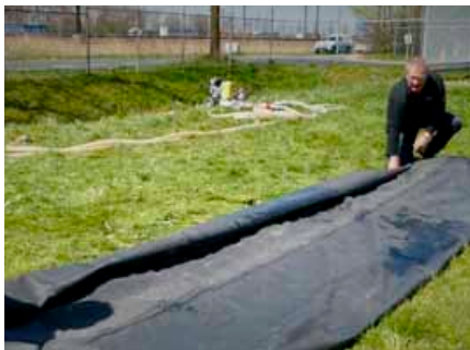
Sla de SLAMDAM® een kwart terug aan de linkerkzijde.
