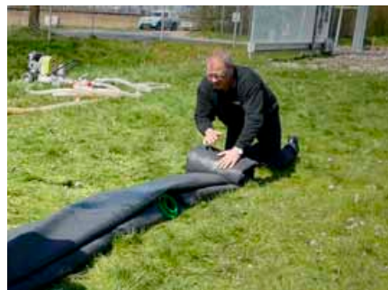
Rol de SLAMDAM® zo strak mogelijk op, van beide zijden, richting de vuldoppen.
