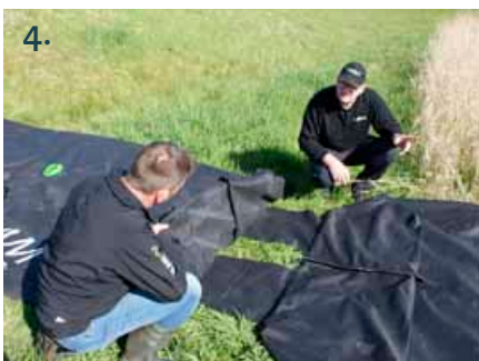
4. Plaats de tweede SLAMDAM® leeg in de lengte-richting.
