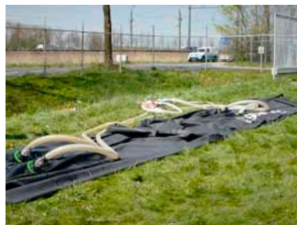
De SLAMDAM® is nu gereed om te vullen. De 2 compartimenten van de SLAMDAM® dienen tegelijkertijd gevuld te worden.
