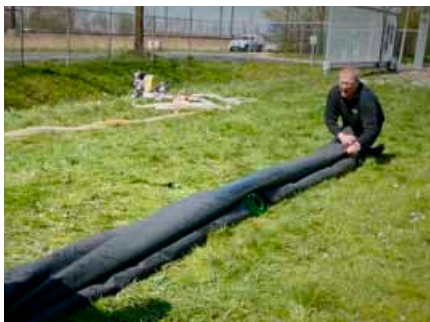
Zorg dat de vuldoppen vrij blijven, zo kan eventueel restwater weglopen.
