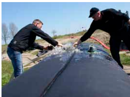
Ontlucht de SLAMDAM® tijdens het ontkoppelen van de vulslang.
