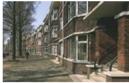
6. Portiekwoningen aan de Thorbeckelaan
