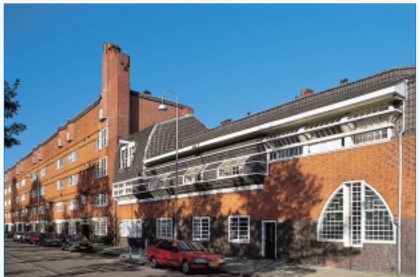
△ De Amsterdamse School was erg barokgericht. De kozijnen vormen één geheel met de gevel (Spaandammerplantsoen, Amsterdam; ontwerp: M. de Klerk).
