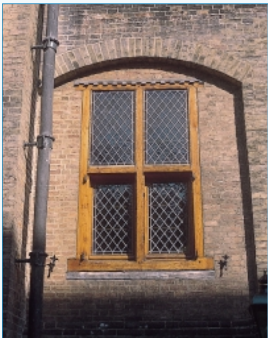
△ Kruiskozijn in de Ridderzaal aan het Binnenhof te Den Haag: 'wybertjes' in een transparant afgewerkt eiken kozijn met oren.
