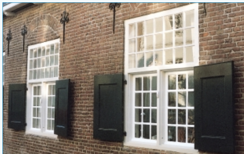
◁ Overgangsvorm kruiskozijn met niet meer in tweeën gedeeld bovenlicht (Agnietenhof, Utrecht).
