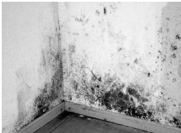
Beispiele für Schimmelpilzbefall im Wärmebrückenbereich.
