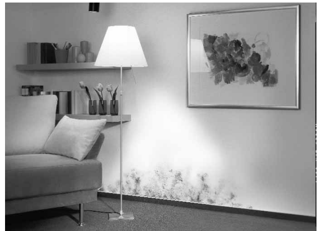
Beispiele für Schimmelpilzbefall im Wärmebrückenbereich.
