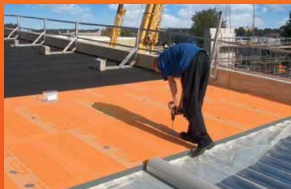
plat dak isolatie
