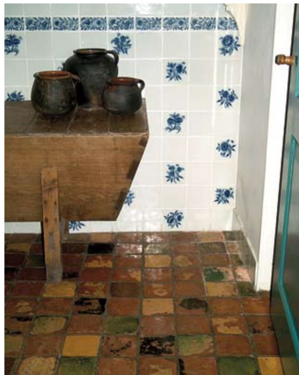
Monumentale vloer in rijksmonument - privé woning
