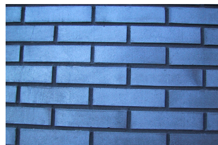
Foto 4: Woningen te Zwolle: Een ongeveer 10mm verdiepte “sinaasappelstructuur” met een donkere voeg.
