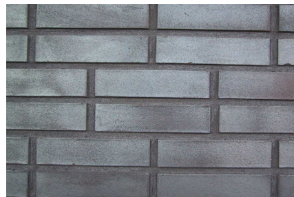
Foto 3: Kantoor te Zwolle: De voegen zijn afgewerkt met een voegijzer en er zijn “platvolle” gladde voegen gemaakt.
