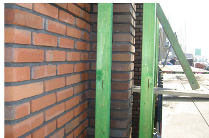
Foto 11: Profielen bij het stellen +/- 10cm los houden van het metselwerk.
