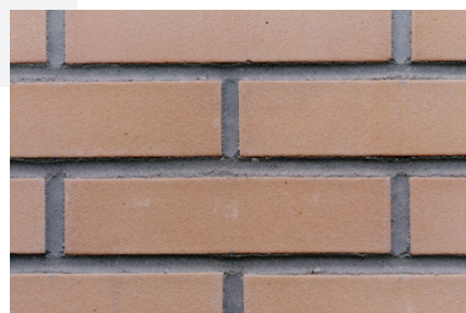
Foto 2: woningen te Hoogkerk: De voegen zijn hier afgewerkt met een pointmaster waardoor een holle gladde voeg is ontstaan.
