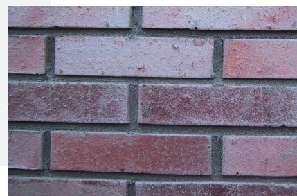
Foto 6: Kantoor te Apeldoorn: Een 10mm verdiepte “sinaasappelstructuur” met een donkere voeg
