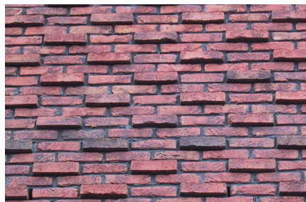
Foto 12b: Stadskanaal, 1999: centrumplan – winkels en appartementen aan het raadhuisplein, paars genuanceerde steen, doorstrijken met donkere mortel, uitgekraab en speciaal kruisverband.
