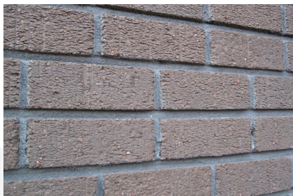
Foto 16b: Deventer, 2003: Appartementen Pothoofd aan het Pothoofd, donkerbruine geschraapte strengperssteen, antraciete gladde voeg.
