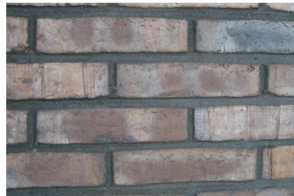
Foto 20b: Amsterdam IJburg, 2008: Appartementen aan de Johan Huijsenstraat, waserstrichsteen dik en waalformaat, platvolle en verdiepte voegen.
