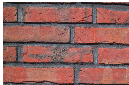
Foto 14b: Groningen, 2000: Appartements aan de Pioenstraat doorstrijken met een antraciete metselmortel, 5 mm. terugliggend, Paarse sterk genuanceerde handvormsteen.
