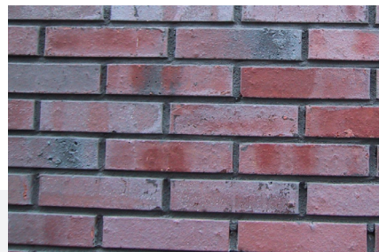
Foto 17b: Apeldoorn, 2003: Hoofdkantoor van de ABN bank aan de Wapenrustlaan, Paars geëngobeerde stenen met veel vormstenen, zwarte uitgekrabde stoot en lintvoegen, stootvoegen zijn niet strak.
