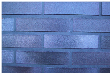
Foto 13b: Almere, 2000: Hoofdkantoor PricewaterhouseCoopers advocaten aan de Tunerstraat, genuanceerde zwart glimmende steen, zwarte doorgestreken gladde platvolle voeg.
