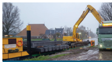
Damwandplanken in antracietkleur op transport
