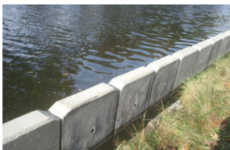
Damwandplanken met splintervrije koppen
