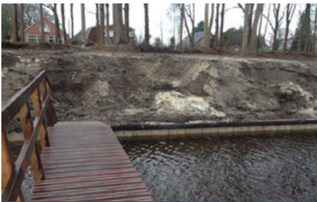
Fraai werk met hardhouten gording
