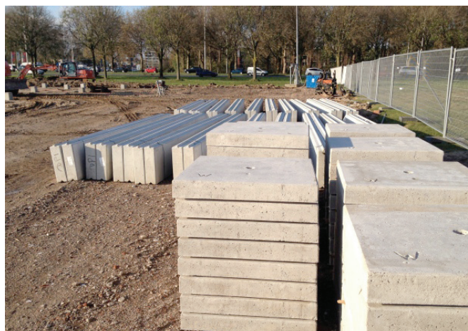
Ankerplaten en damwandplanken gereed voor plaatsen
