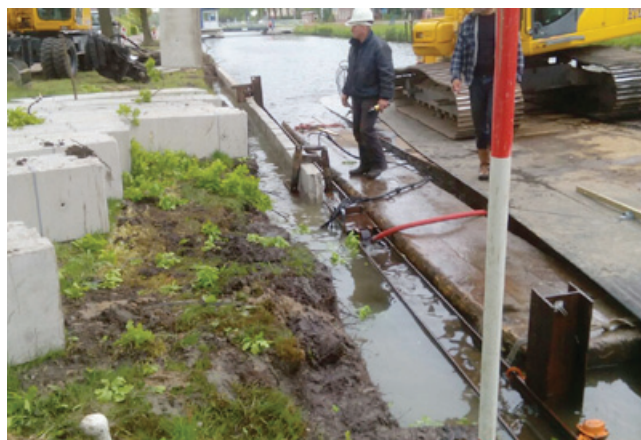
Plaatsen damwandplanken langs geleidebalk
