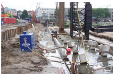
Geleidebalk hulpconstructie voor het plaatsen van damwandplanken
