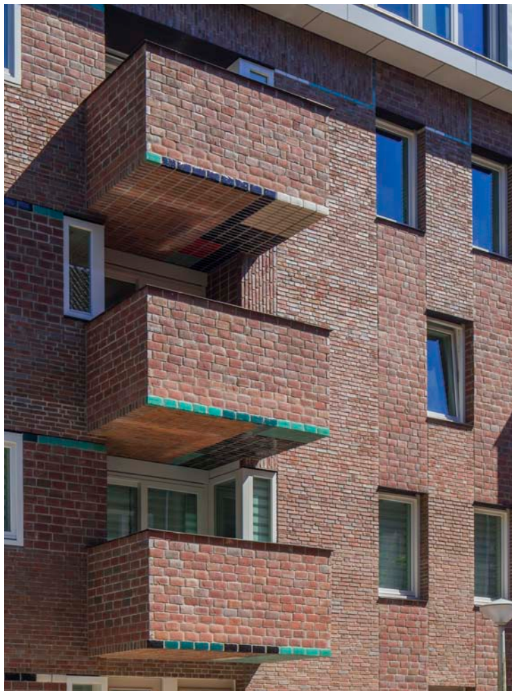
Iedere straatwand zijn eigen sfeer. Er is veel aandacht gegeven aan de metselverbanden.
