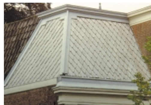
Kenmerkend dak uit de tweede helft van de 19de eeuw met zinken losanges, goot, boekkepers en dakrand (foto K. Boeder)
