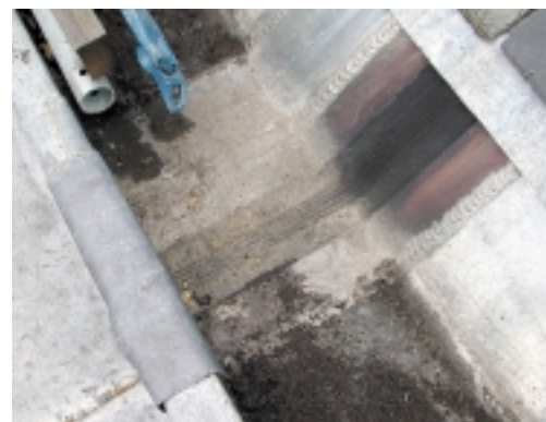
Waar een broekstuk niet mogelijk is, wordt een rubberen expansiestuk toegepast. Dit heeft echter een beperkte levensduur en gaat op den duur barsten vertonen
