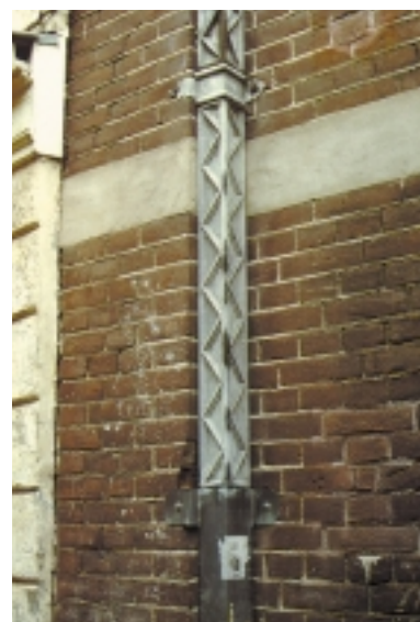
Bijzondere geperste zinken afvoerpijp. Door soms onnodige vervanging worden ze zeer zeldzaam (foto K. Boeder)
