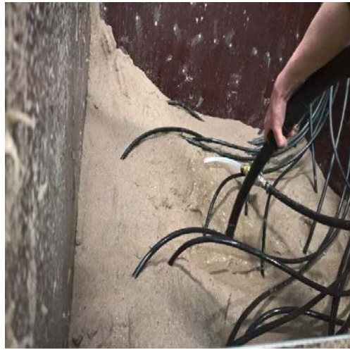
Figuur 30: Injectielaag beproeving 4
