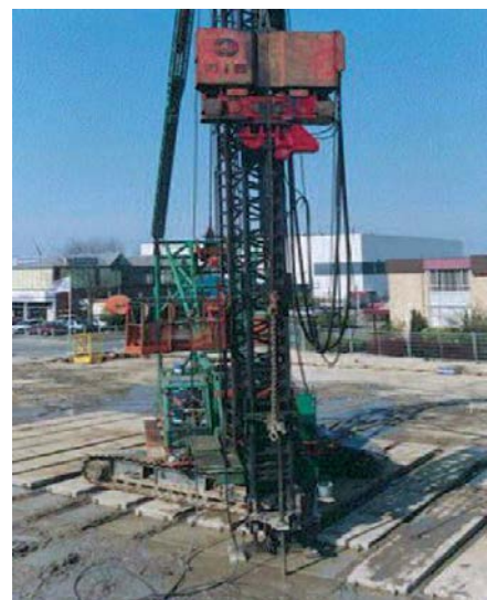
Figuur 8: Voorbeeld inboren injectiepunt
