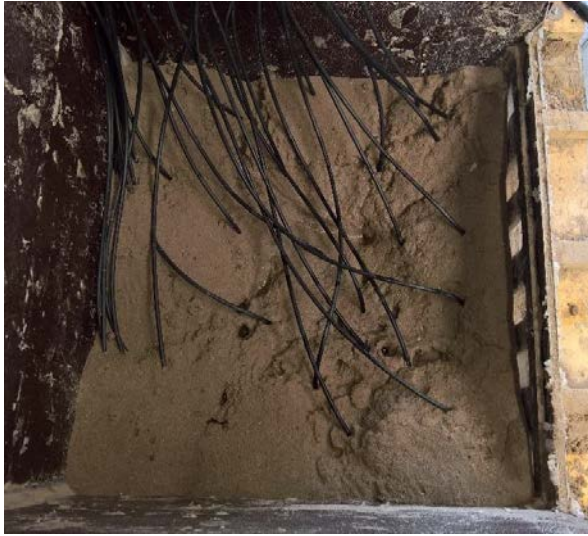
Figuur 32: Injectielaag beproeving 5
