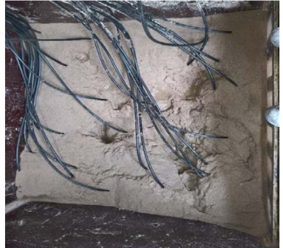
Figuur 25: Injectielaag beproeving 3
