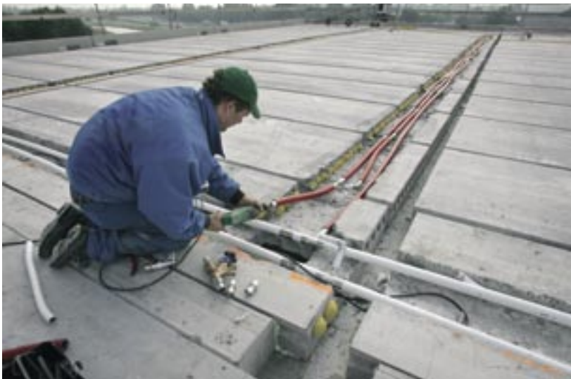
Figuur 9 Betonkernactivering in prefab beton en gietbouw
