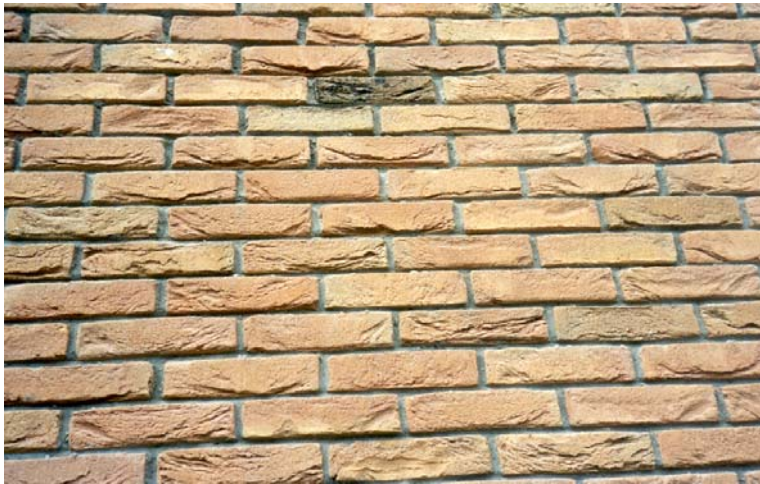
Figuur 1. Doorgestreken metselwerk met handvormsteen.
