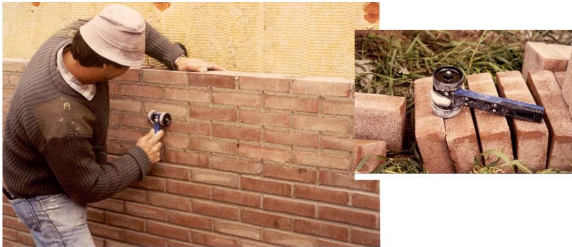
Figuur 2. Metselaar bezig met doorstrijken van de stoorvoegen met een voegroller.
