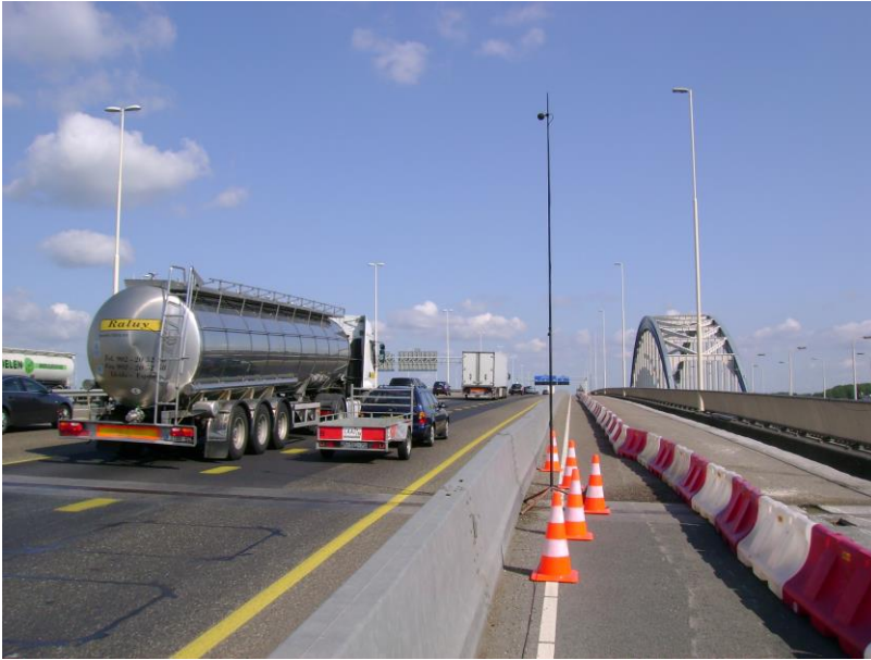
figuur 6 geluidmeting aan een voegovergang
