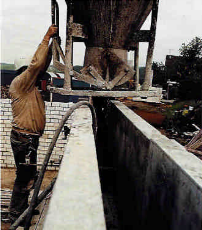
Het gieten van een kelderwand met een vezelversterkt beton.
