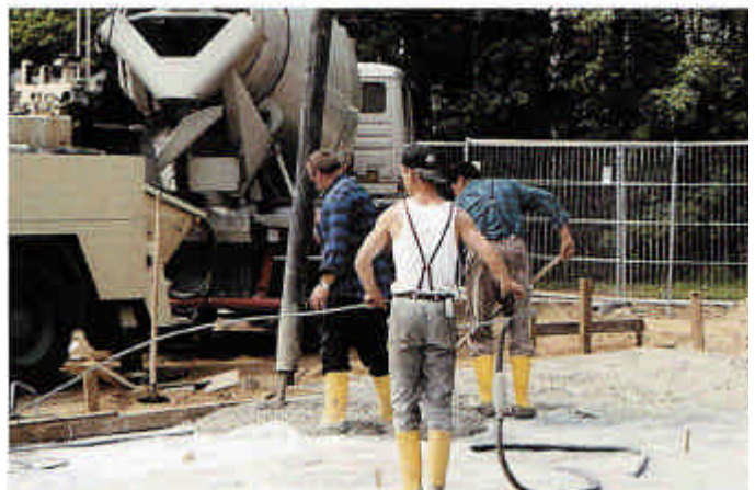
Het gieten van een vloer met vezelbeton van Fortius
