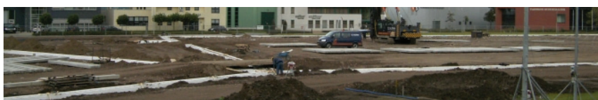
Utiliteitsbouw, Deventrade, Deventer Aannemer: Aan De Stegge, Twello (ADST)
