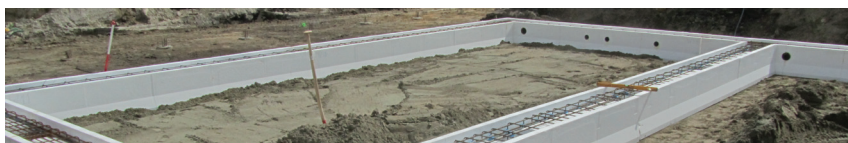
Woningbouw, De Kroeven, Roosendaal Aannemer: BAM Woningbouw, Breda
