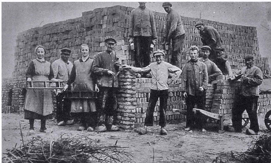
Het stapelen van stenen in een veldoven
