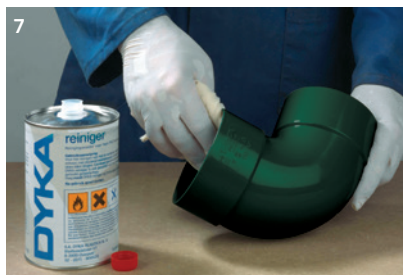
7 Binnenkant fitting reinigen
