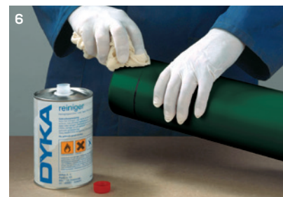
6 Buiseinde reinigen met DYKA reiniger
