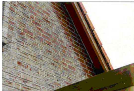
Figuur 5: Vergrauwing: kenmerkend is de scherpe begrenzing tussen het beregende en droge deel van de gevel.
