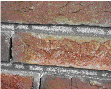
Figuur 1: Kalkafzetting in de poriën.
