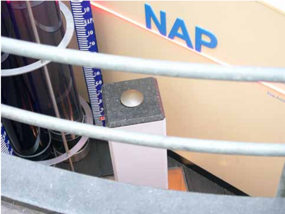
27 Het nulpunt (referentieniveau) van de hoogtemetingen in Nederland ( 0 meter NAP).
