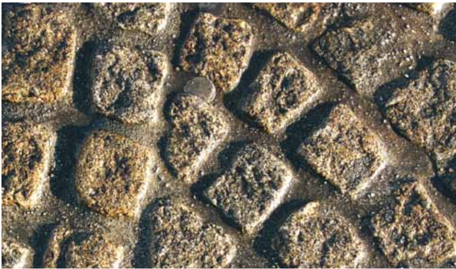
15 Graniet als bestrating op de Dam.
