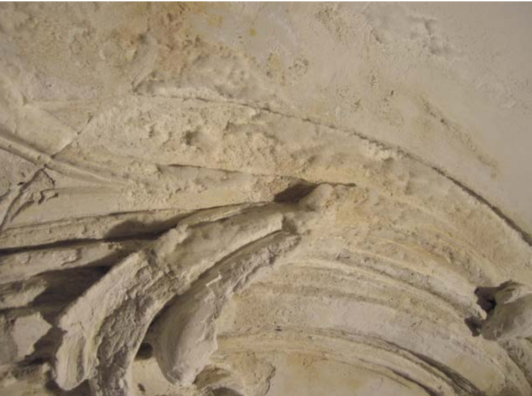
Zoutuitbloei ontstaat als je stucwerk onvoldoende reinigt na een verfabijtmiddel gebruikt te hebben
