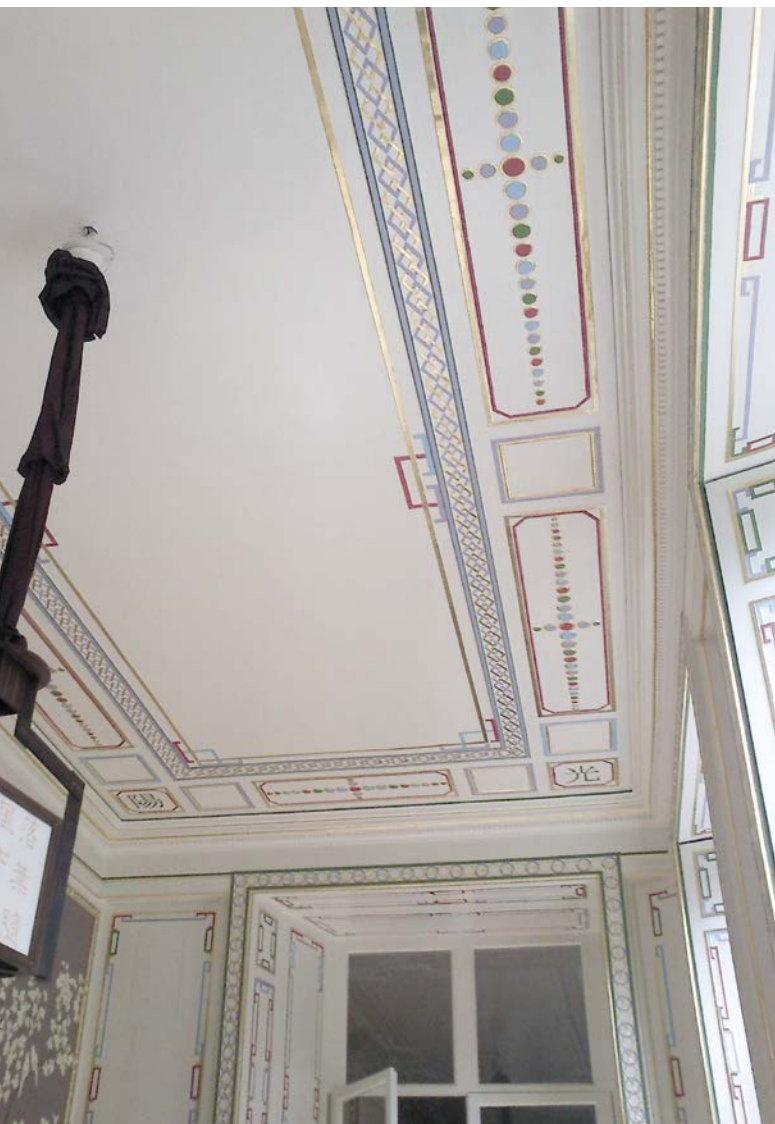
Na een brand is de schade aan dit stucplafond met veel vakmanschap volledig hersteld
