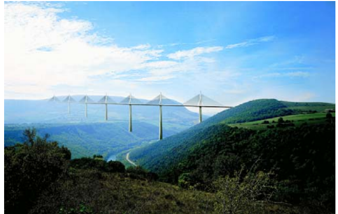
figuur 1.8 Brug bij Millau (Frankrijk)
