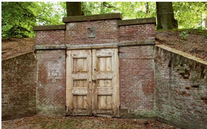
In ijskelders houdt de spouw warmte buiten. Hier de ijskelder uit 1850 van Paleis Soestdijk
