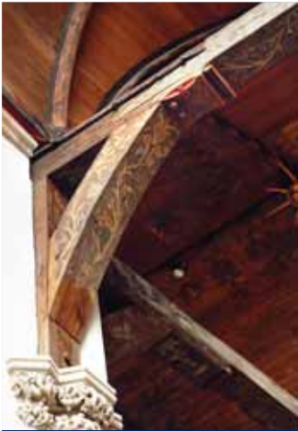
Boven: Oude Kerk Amsterdam, de oudste in Amsterdam aanwezige profilering van sleutelstukken met een peerprofiel. Gebouwd: ±13 e eeuw.
