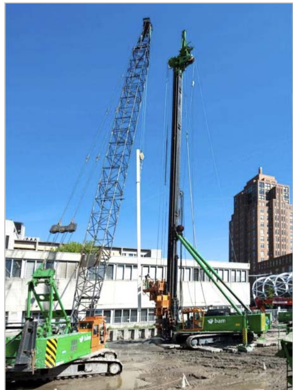
Aangeven prefab kern
