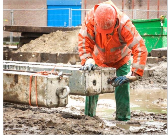
Afhangen prefab kern in boorbuis
