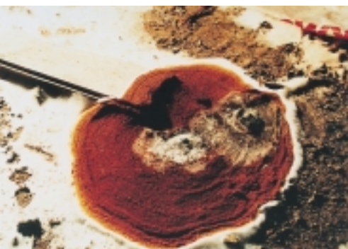
Huiszwam - vruchtlichamen (in plaatvorm). Vruchtlichamen van de huiszwam komen vaak voor op de overgang hout - muur (boven) of op de bodem in kruipruimten (onder)
