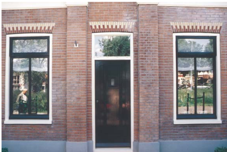
Figuur 5. Anderhalfsteens strekken boven kozijnen.
