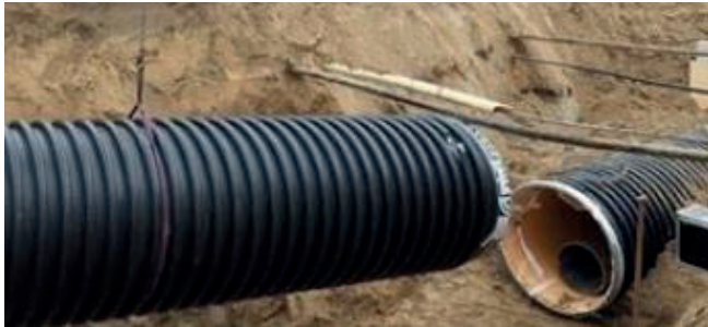
FIGUUR 5 AANLEG FRANK BUIS BIJ VELLESAN COLLEGE
