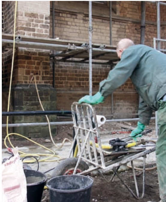
Handmatig injecteren van holle ruimten met een minerale mortel
