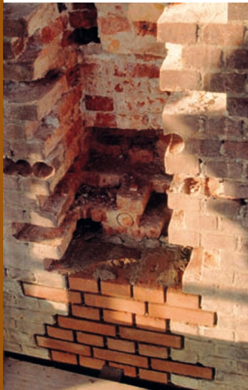
Metselwerk waarbij om constructieve redenen diep wordt ingeboet
