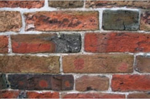
Veertiende-eeuwse bakstenen gestookt in een veldbrandoven. Temperatuurverschillen en de wijze van stapeling in de veldoven leidden tot een mooi gemêleerd kleurenpalet (foto Albert Reinstra)
