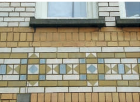
Vroegzestiende-eeuws metselwerk met touwbandmotief. De gele stenen zijn kalkrijk, de rode ijzerrijk (foto Albert Reinstra)
