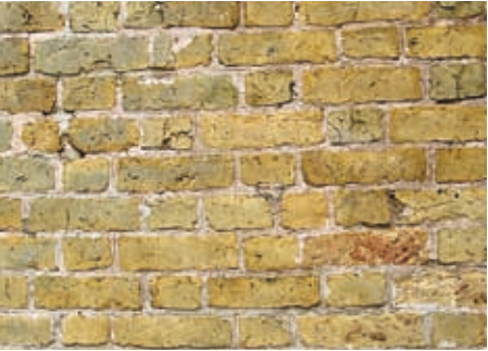
Metselwerk opgetrokken in kistwerk (foto Albert Reinstra)
