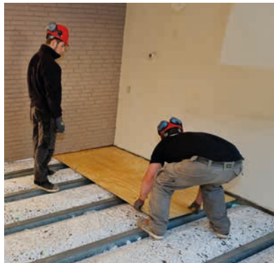
PS-renovatievloer Droog afwerking met plaatmateriaal.
