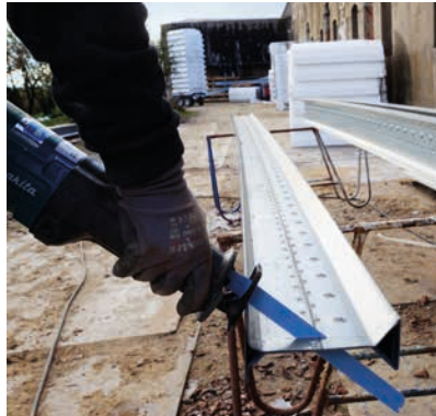
Indien nodig zijn de liggers eenvoudig af te korten.
