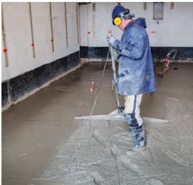
PS-renovatievloer Standaard afwerking met betonnen druklaag.
