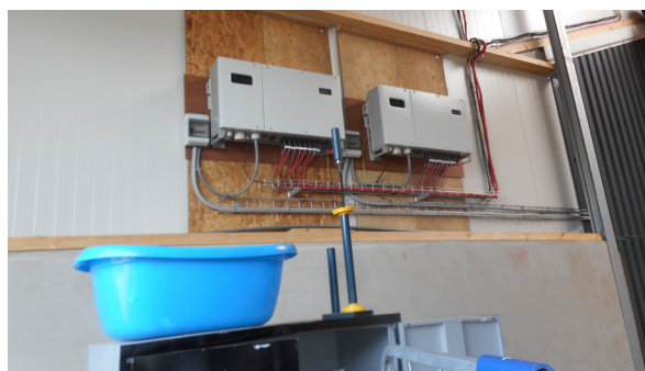
Omvormers op een brandbare ondergrond bevestigd. Foto: SOBH.
