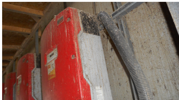
Omvormers in kippenstal. Foto: SOBH.
