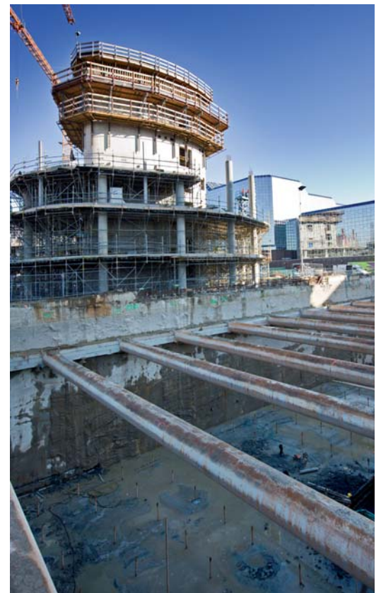
Figuur 12 Kantoortoren en parkeergarage in aanbouw, september 2008. Foto: Hans Rogge
