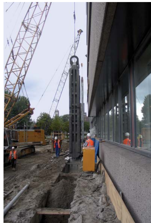
Figuur 8 Installeren diepwand vlak voor bestaand kantoorpand. Foto: Marco Kimenai
