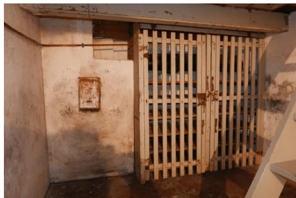
124. Provisiekast met links de muur waarin het gietijzeren schoorsteenvegersluikje zit.
