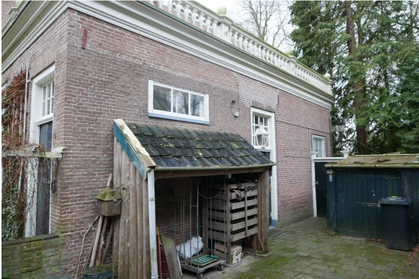
55. Noordelijke aanbouw, noordgevel.
