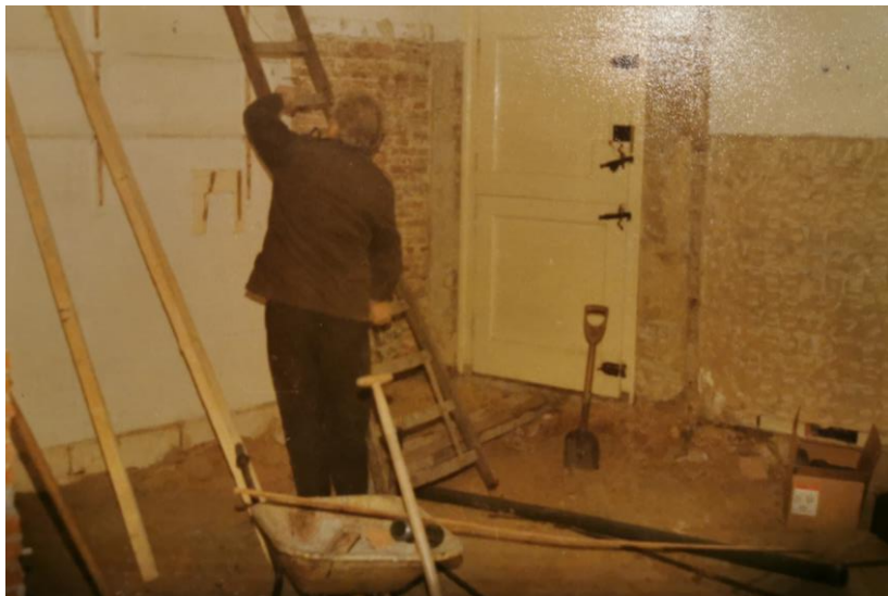
188. De keuken tijdens de verbouwing in 1979. De scheidingsmuur met de provisiekamer is gesloopt. De deur is de halve buitendeur uit 1960.
