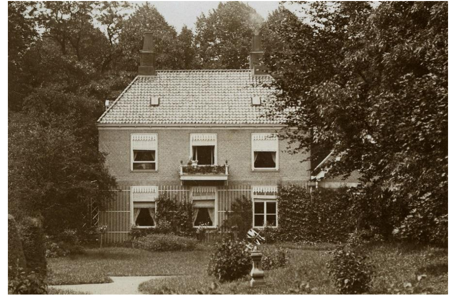
12. Foto achterzijde omstreeks 1895. De grens tussen het oude en nieuwe metselwerk is duidelijk te zien door het grotere steenformaat en de 'verse' voegen. In de oude situatie bedekte de vroegere daklijst de zes laatste lagen metselwerk boven de hanenkammen. De raamvensters zijn voorzien van lamberkijnen met jaloezieën. De hoeken van de schuiframen zijn afgerond, met uitzondering van het rechter raam, dat een 6-ruitsverdeling bezit en draairamen heeft. De gietijzeren dakramen zijn al aanwezig.
