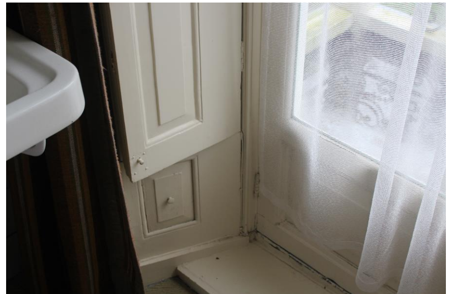
238. Hergebruikte 18 de -eeuwse vouwblinden bij venster badkamer.
