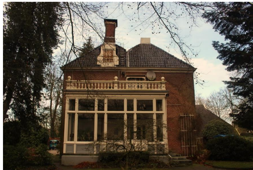
45. Zuidgevel met serre.
