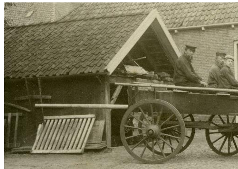
337. Detail. Verdiepte potstal.
