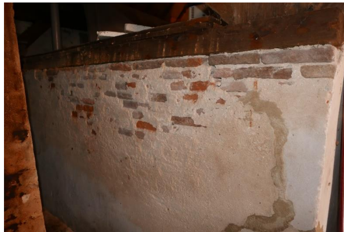
288. Handvorm vechtstenen binnenmuur tuigkamer.
