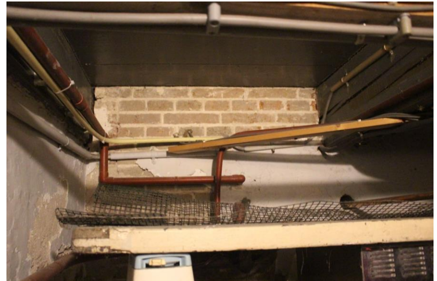
204. Zicht op voormalige buitenmuur van oudste gedeelte aanbouw.
