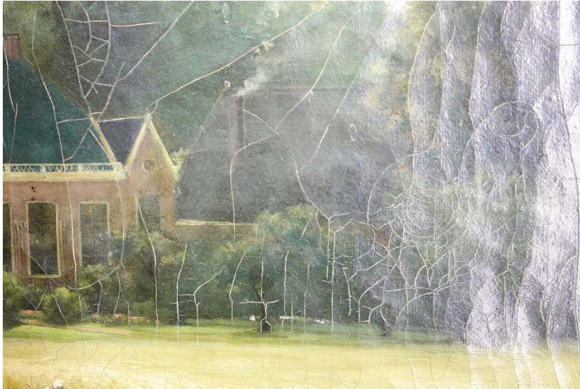
318. De enige afbeelding van het oude koetshuis vinden we op het schilderij van Petrus Kiers, dat voor 1868 vervaardigd is. Het gebouw is helaas nauwelijks zichtbaar. Toch vallen een aantal dingen op: de hoogte was al fors, het dak was net als nu met pannen gedekt, de schoorsteen zat op dezelfde plek. Het belangrijkste verschil: de voorkant had geen wolfseind maar een hoge tuitgevel.
