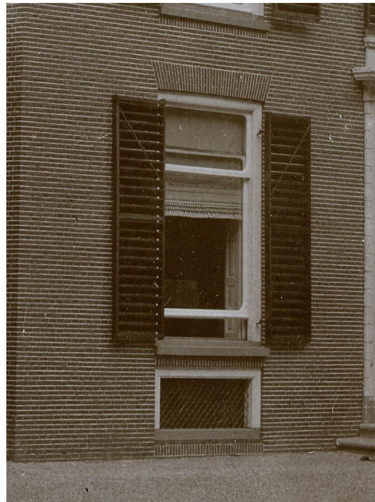
126. Op dit fotofragment uit 1895 is te zien dat de naaikamer een opkamer was: binnen staat een stoel op vensterbankhoogte. Verder heeft het 19 de -eeuwse schuifraamvenster nog zijn 18 de -eeuwse vouwblinden. In het kelderraam is een luik met twee ronde of ovale ramen aangebracht. Zo'n zelfde luik is nu nog aanwezig bij het raam van de kelder onder de mangelkamer.
