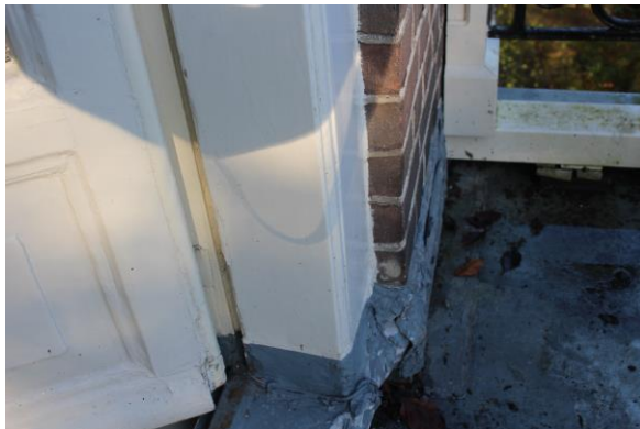
237. Openslaande glasdeur bij het balkon.
