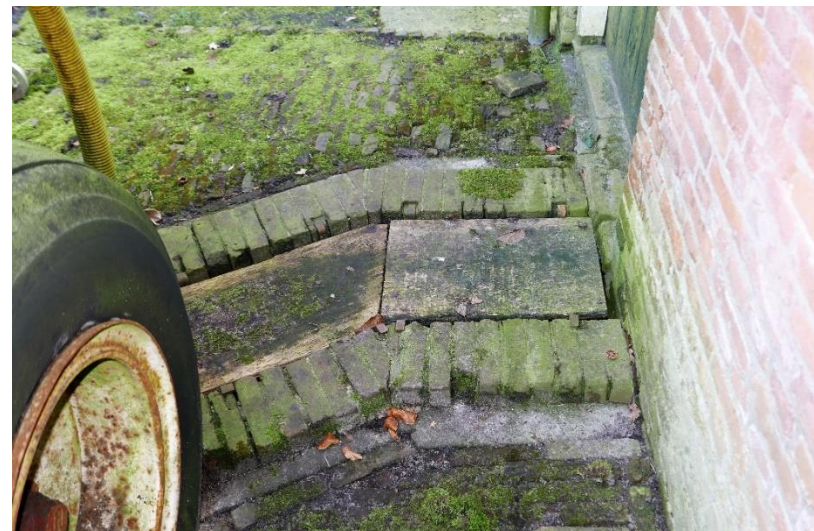
309. Mestgoot buiten de achtergevel.
