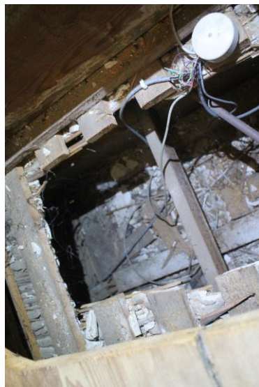
226. zicht op bovenkant oud stucplafond en huidig
