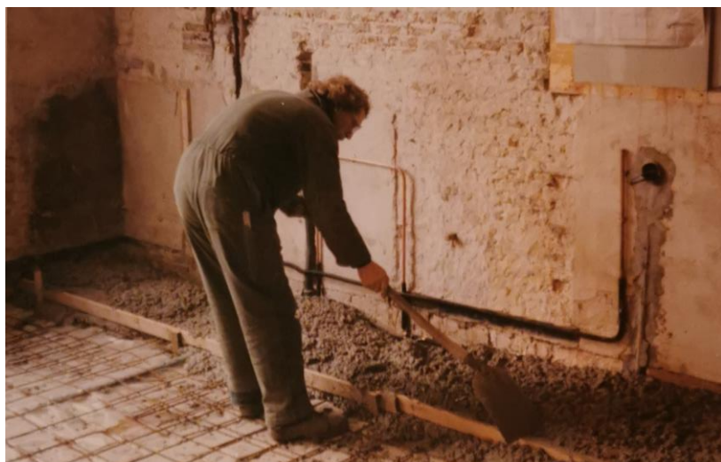
190 - 191. Storting van de betonvloer in de keuken, 1979.
