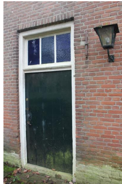
266. Staldeur met bovenlicht.
