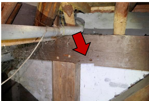
278 - 279. Loze pengaten in de dekbalk achter de voorgevel.
