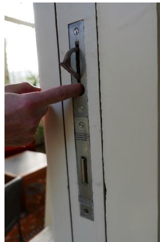
170 - 172. Sluitwerk van de schuifdeur tussen salon en serre.
