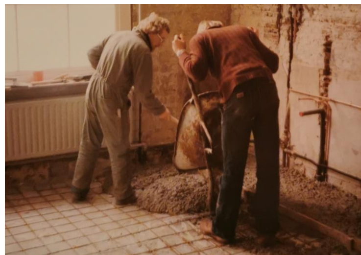
189. Dezelfde hoek na herbouw van de scheidingsmuur, storting van de betonvloer en aanleg van de vloerverwarming.
