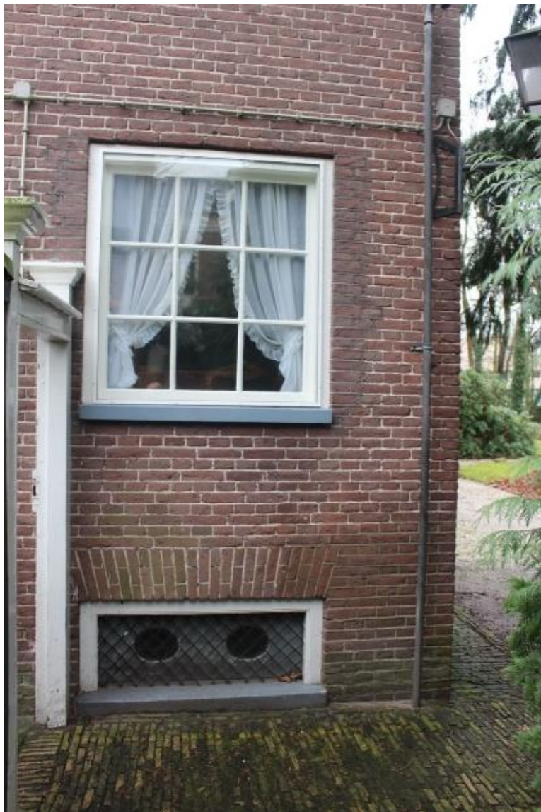
59. Hoek met kelderraam en venster mangelkamer. Rondom dit raam is het metselwerk aangepast.
