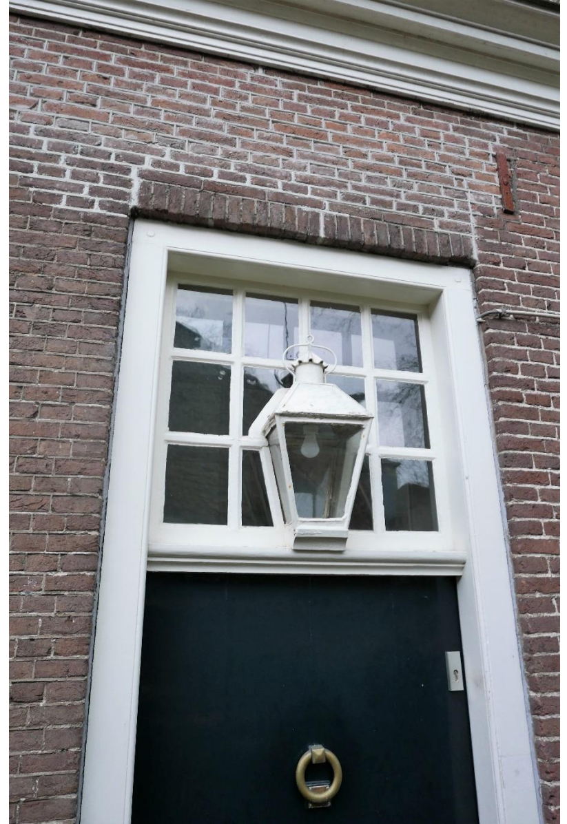
58. Bovenlicht zijentree met aangepast metselwerk erboven.
