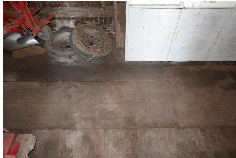
333. Mestgoot afgedekt met planken.
