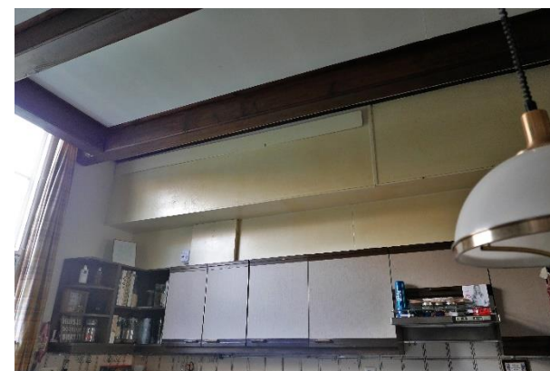
183. Bevinden zich achter deze aftimmering nog restanten van de keukenschoorsteen?
