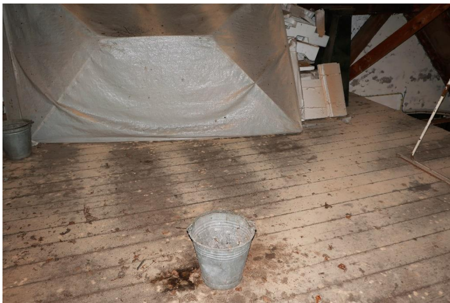
314. Zolder boven tuigkamer.
