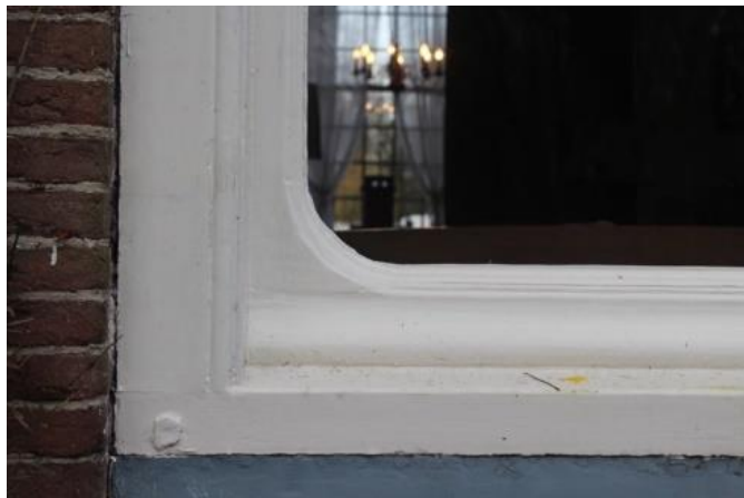
76. Kozijn met toognagel. Het raam heeft een weldorpel en afgeronde hoeken. Onder het kozijn een zinken spatrand.
