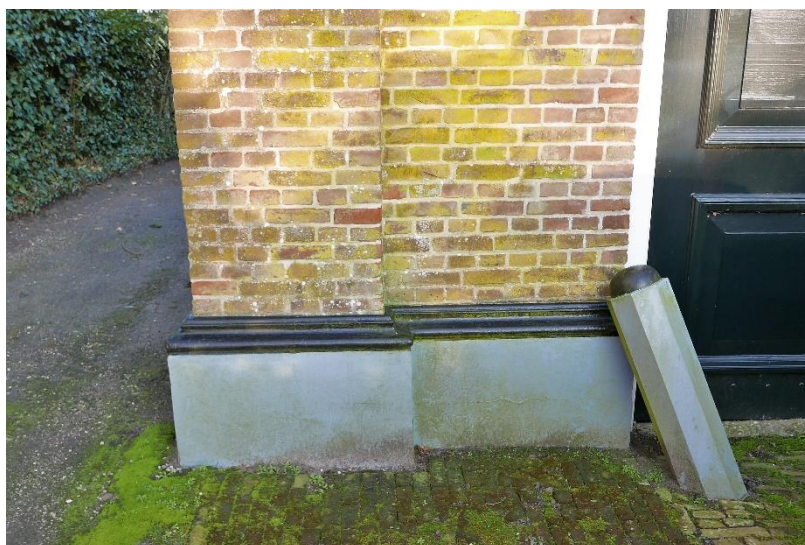
258. Plint en hardstenen paaltje ter bescherming van de hoek.
