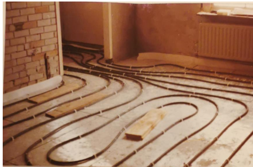
189. Dezelfde hoek na herbouw van de scheidingsmuur, storting van de betonvloer en aanleg van de vloerverwarming.
