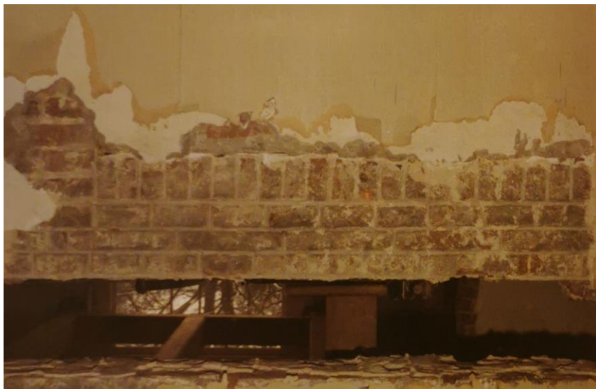
205. Bij de verbouwing in 1979 kwam in de scheidingsmuur van achtergang en mangelkamer de rollaag van een raamvenster tevoorschijn. Onduidelijk is vanuit welke ruimte de foto genomen is.
