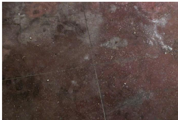
121. In de betonvloer getrokken naden.
