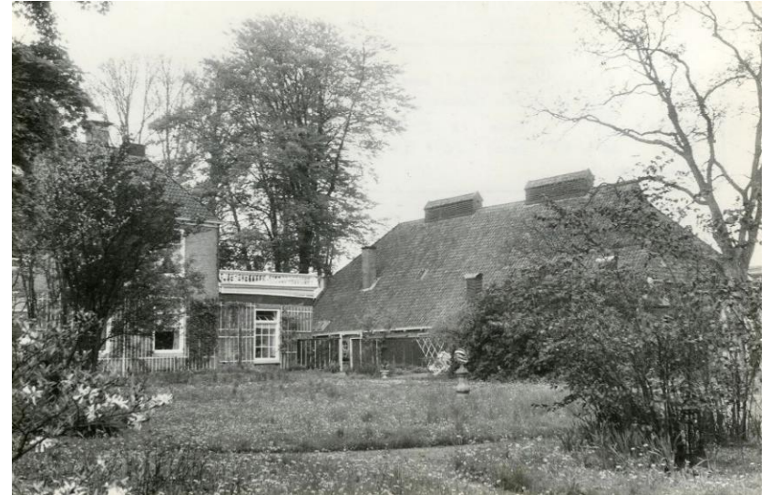
319. Ventilatie-rooster op de nok van het dak, 1957.
