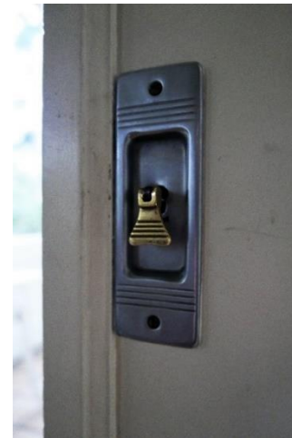
170 - 172. Sluitwerk van de schuifdeur tussen salon en serre.
