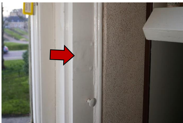
220. Plaatje voor sluitboom verdwenen blinden.
