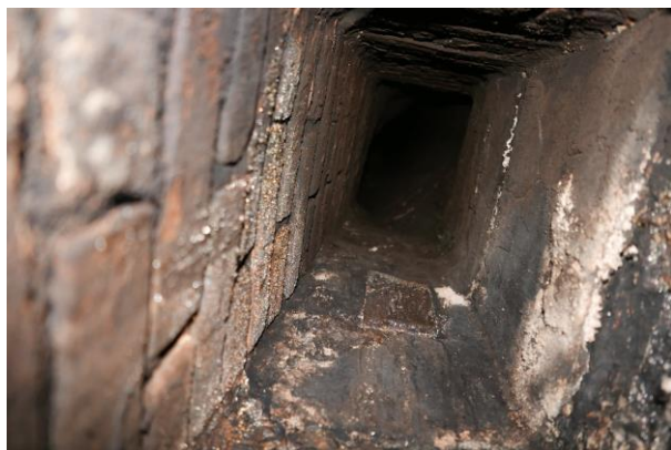
123. 'Verborgen' rookkanaal in noordwesthoek, gezien door het gat van het luikje in de muur.
