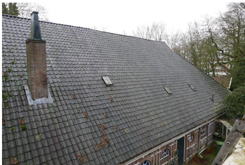
274. Dak aan de zuidzijde.
