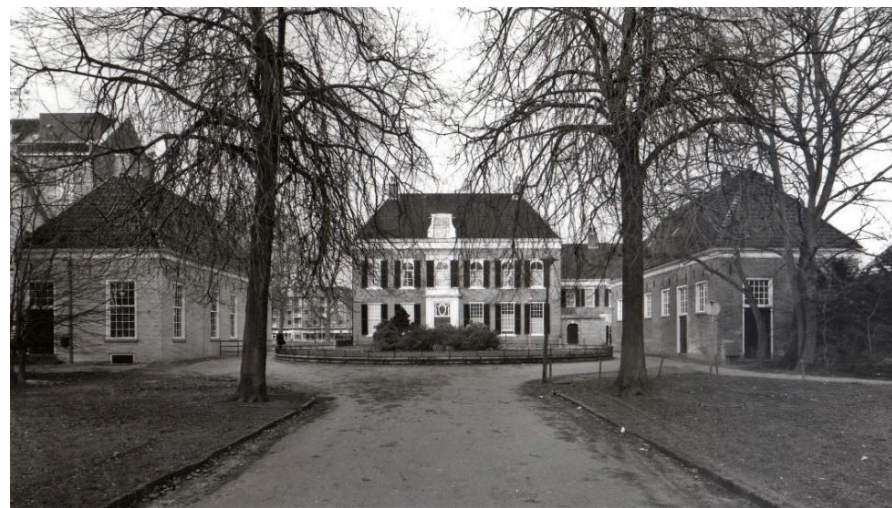
2. Het Drostenhuis in 1977. Het rechter koetshuis werd in 2009 opgevijseld om als entree van het Drents Museum te kunnen dienen.
