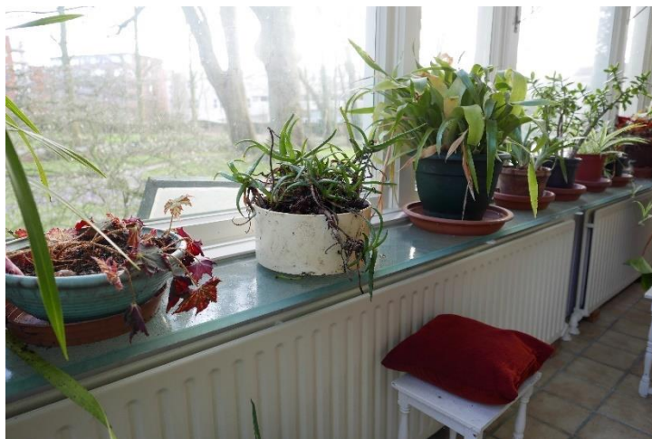
169. Glazen vensterbank met plaatradiatoren, beide uit 1938.
