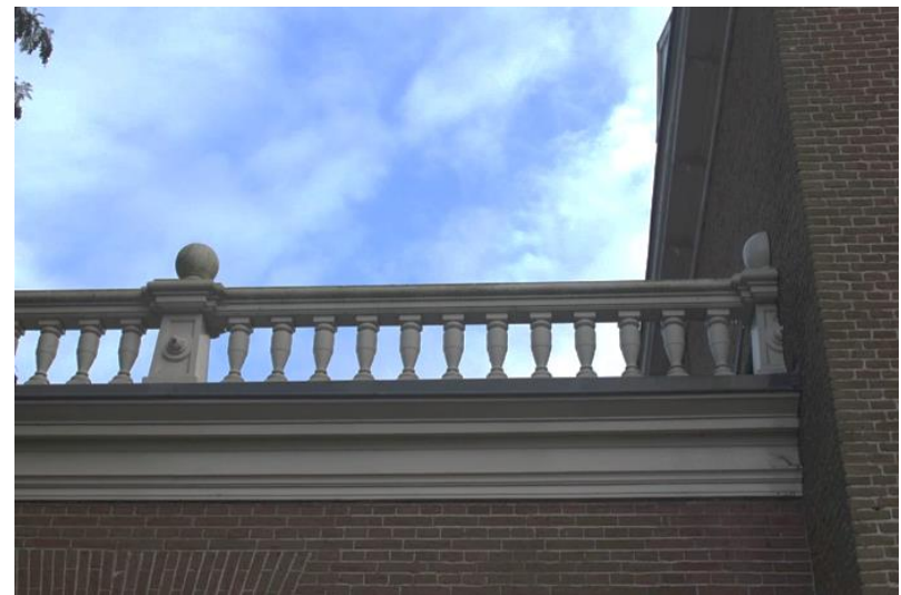
65. Balustrade balkon noordelijke aanbouw.
