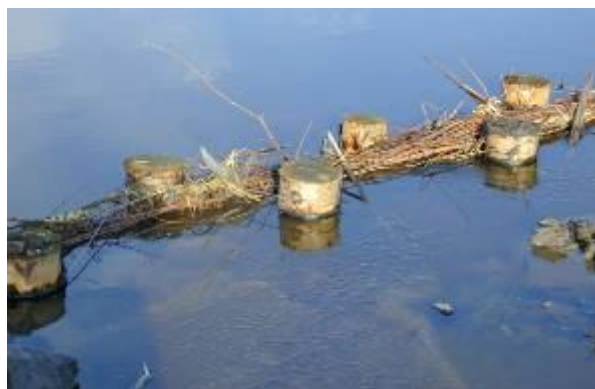
Dubbele palenrij met rijshout ertussen
