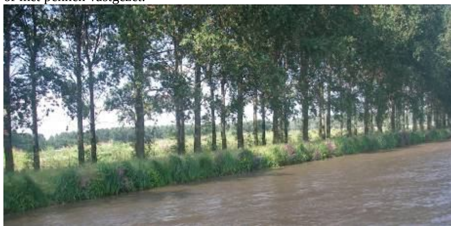
Begroeiing langs scheepvaartkanaal, 1 jaar na toepassen van voorgeplante kokosrollen.
