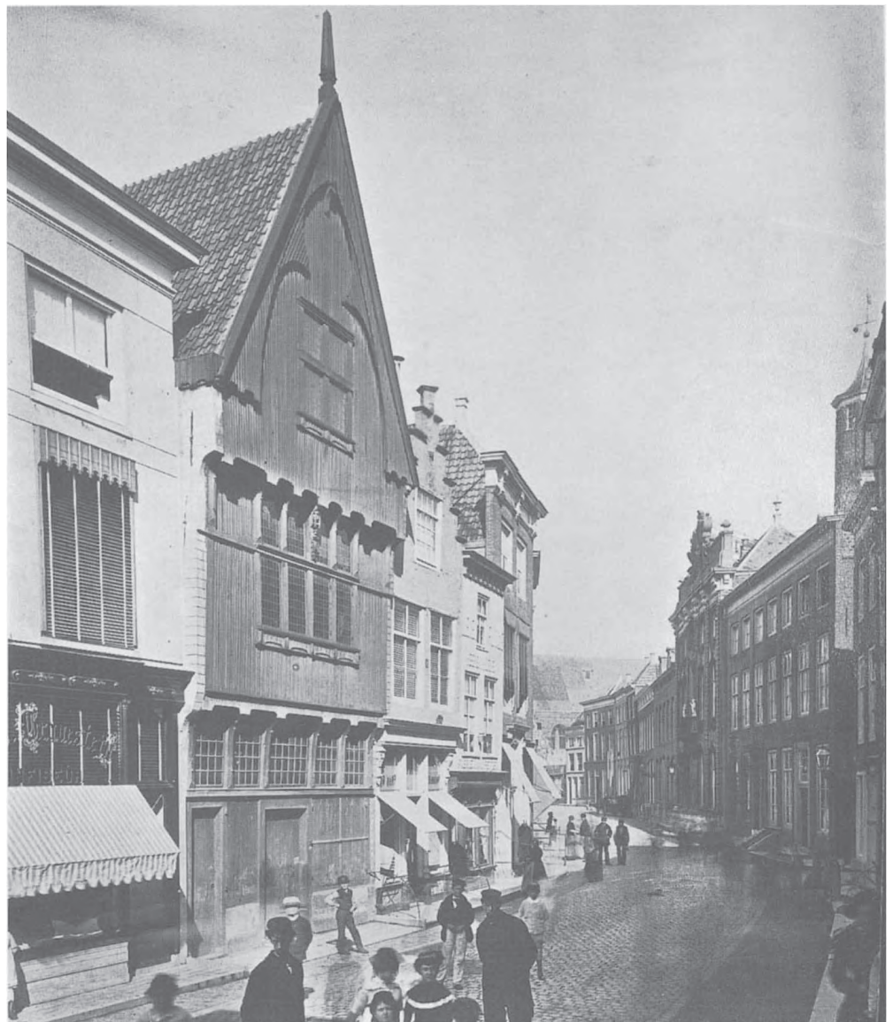
2 Middelburg, Lange Delft. De houten gevel voor de verplaatsing naar de museum-tuin (RAZ). Gering overstek en gebouwd op vlucht.
