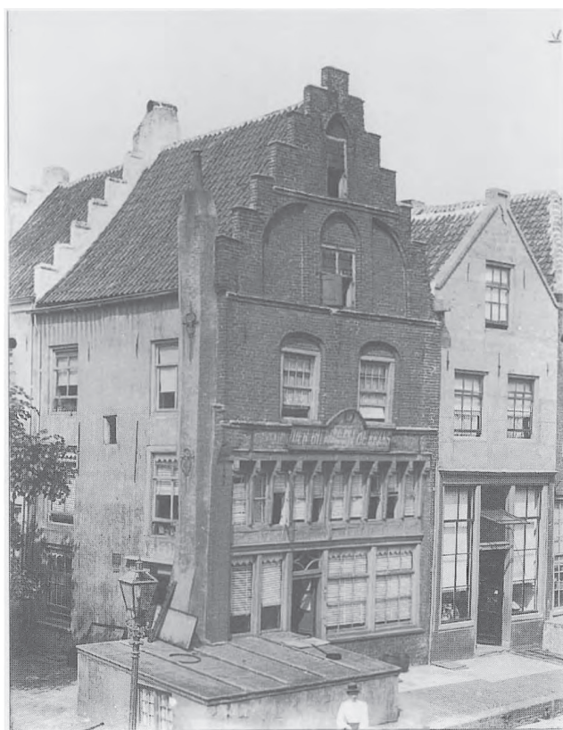
6 Zaltbommel, Markt hoek Waterstraat, (±1525). Bescheiden overstek ter bescherming van de pui.
