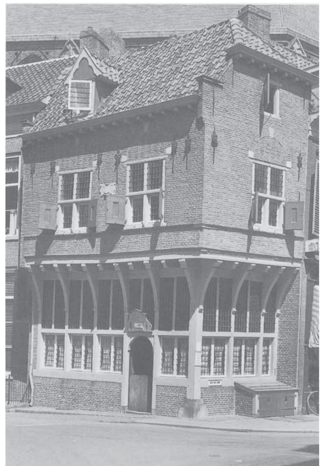
4 Amersfoort, Zevenhuizen 2, na de romantische recon- structie van 1941. De enkel- voudige balklaag is nog grotendeels origineel. De
