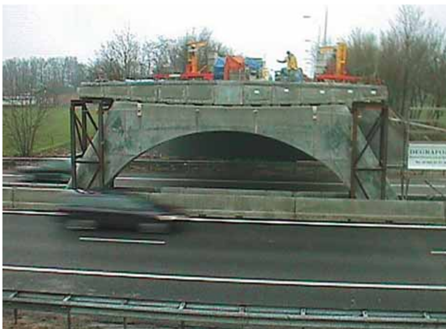
Foto 13.003: Montage vleugelbrug met tijdelijke ondersteuning randligger
