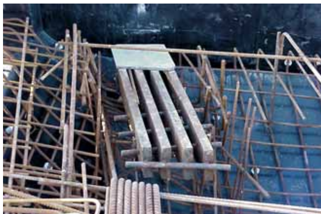
Staalconstructie in het landhoofd
