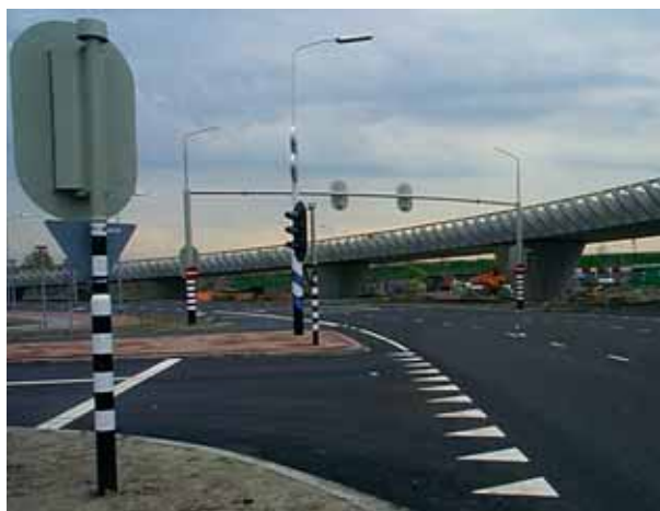
9 | Stand werkzaamheden april 2001
