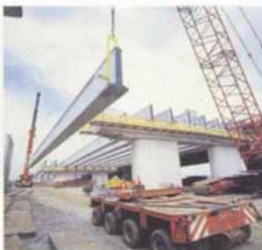
Bild 5. Veränderungen von Länge und Breite bei Fertigteilbrücken in den Niederlanden. Van-Briene-noord-Brücke in Rotterdam (a); Fertigteilträger von über 50 Meter Länge (b); Spannvorrichtung mit einer Kapazität von mehr als 1600 Tonnen (c)
