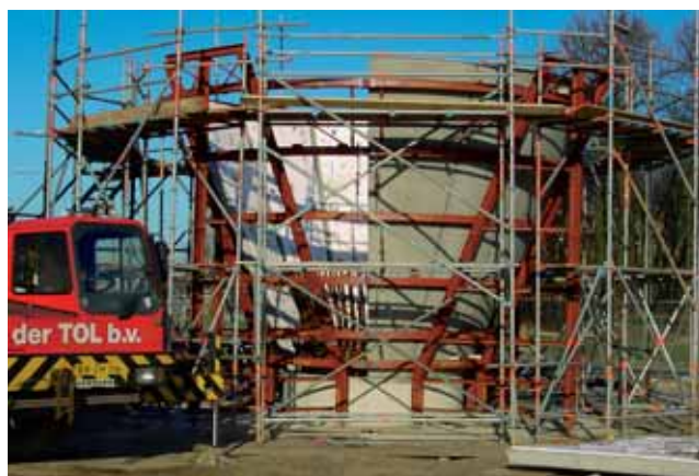
2 | Landhoofd. De inkassing is voor horizontale oplegging van de middelste ligger
