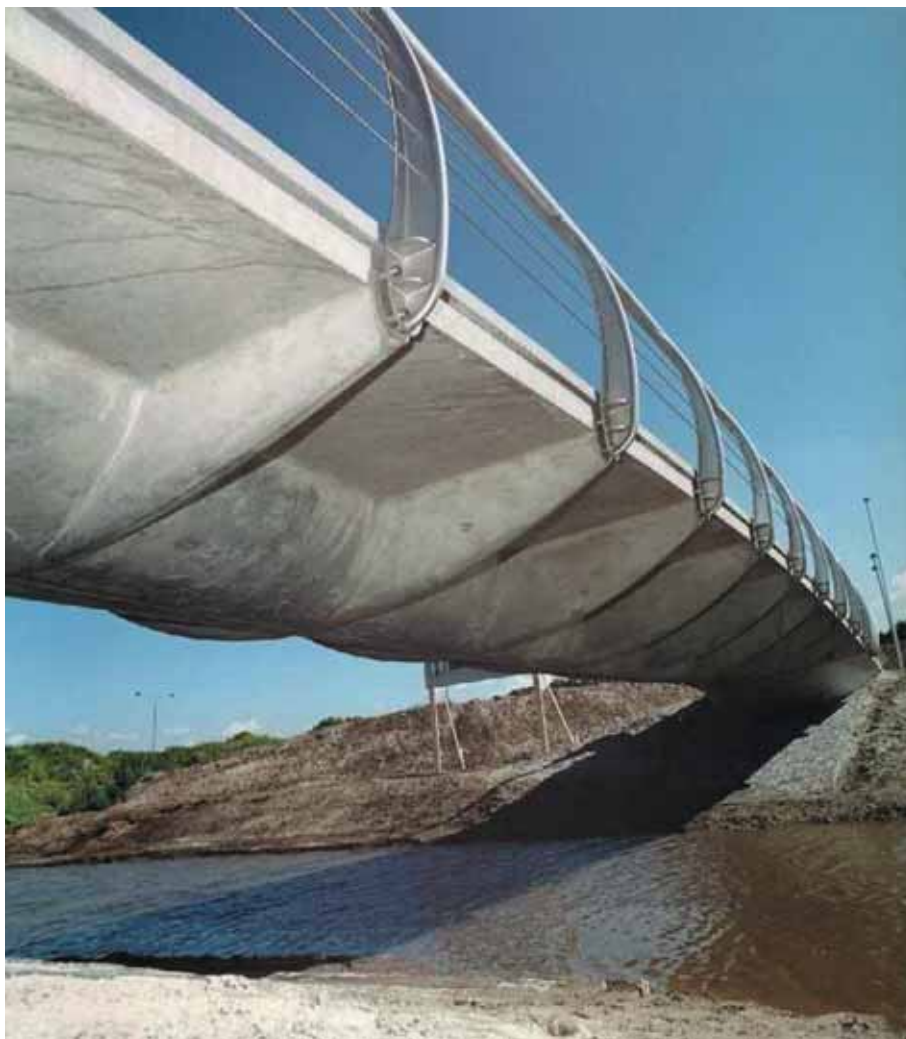
Foto 13.007: Ribcage-brug Vinexlocatie Leidschenveen
