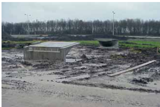
Landhoofden wachten op overbrugging
