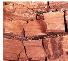
Bruinrot schimmel schade
