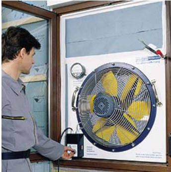
WINCON luchtdichtingstest kwalitatief controle van de luchtdichting onmiddellijk na de uitvoering
